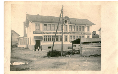
[Façade antérieure de l'usine], entre 1922 et 1935.
