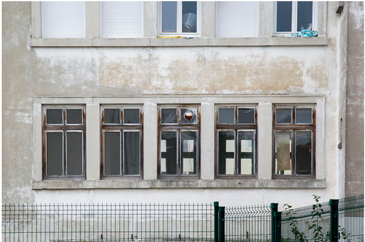
Façade postérieure : fenêtres multiples.
