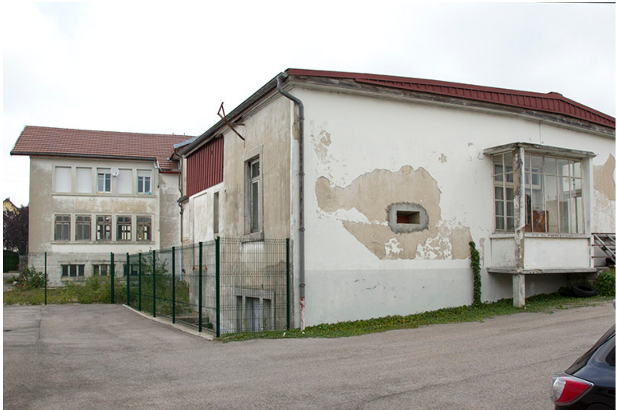
Façade postérieure et extensions.
