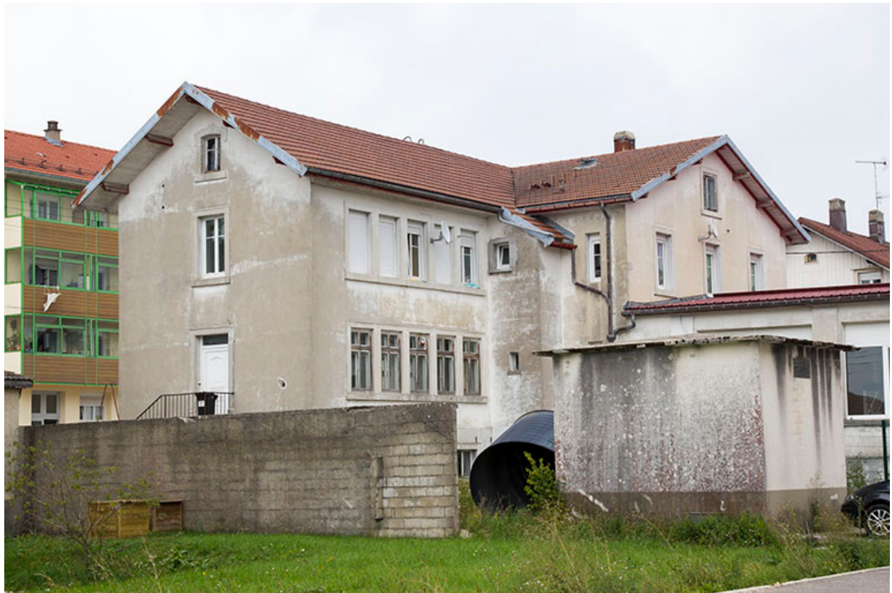
Façades postérieure et latérale droite.
