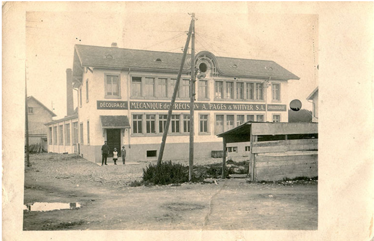
[Façade antérieure de l'usine], entre 1922 et 1935.
