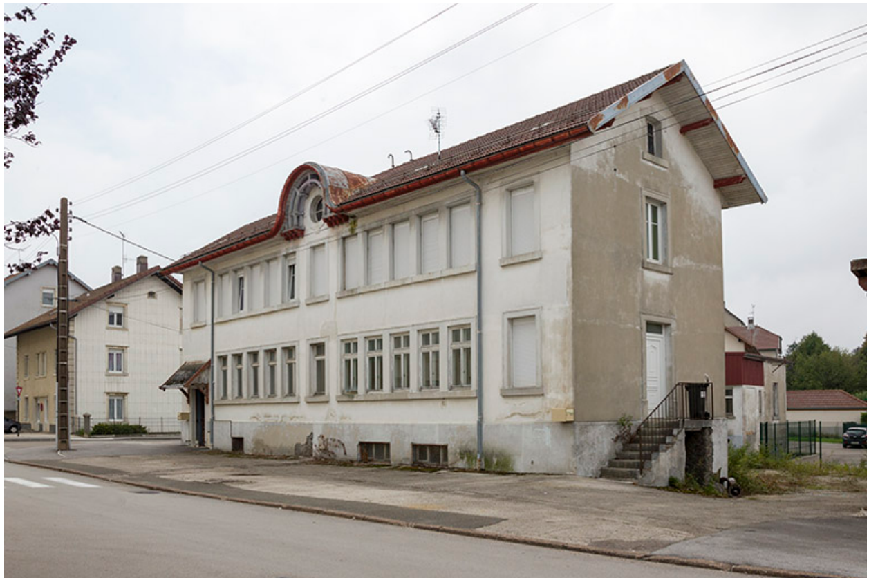
Façades antérieure et latérale droite.
