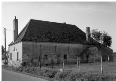
Bâtiment d'habitation, élévation postérieure. Phot. Michel Rosso IVR26_19852101106V
