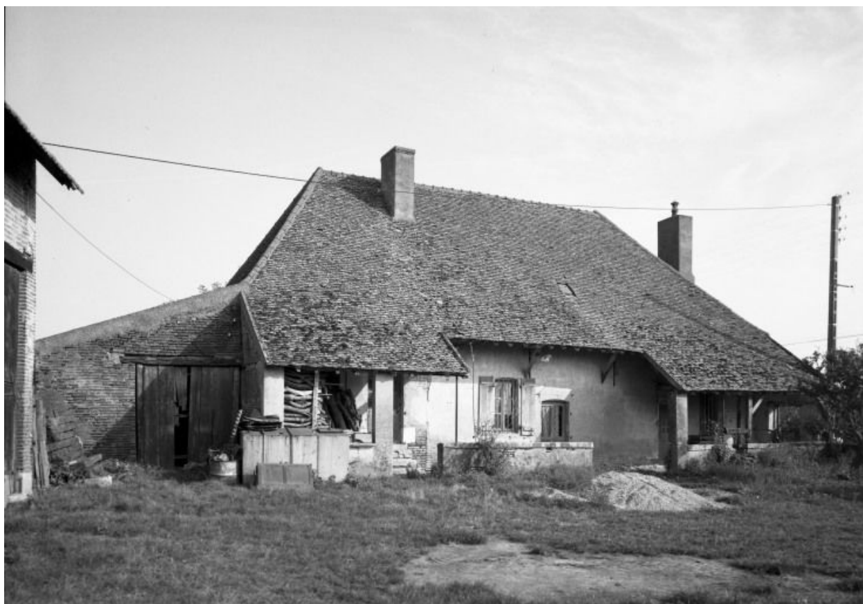
Bâtiment d'habitation, élévation antérieure.
