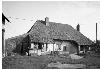
Bâtiment d'habitation, élévation antérieure. Phot. Michel Rosso IVR26_19852101104V
