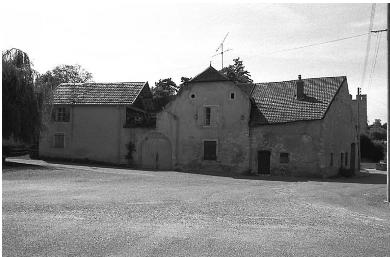
Ferme située rue de Barrey
