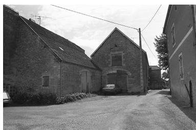
Maison située rue Neuve. Phot. Bernard Lardière IVR43_19817000501Z
