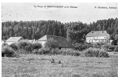
La Forge de MONTAGNEY et le Château. Phot. Yves Sancey IVR43_19847000013X
