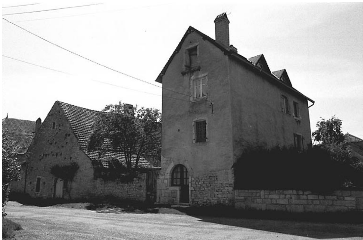
Maison située 2 rue de Bresilley.
