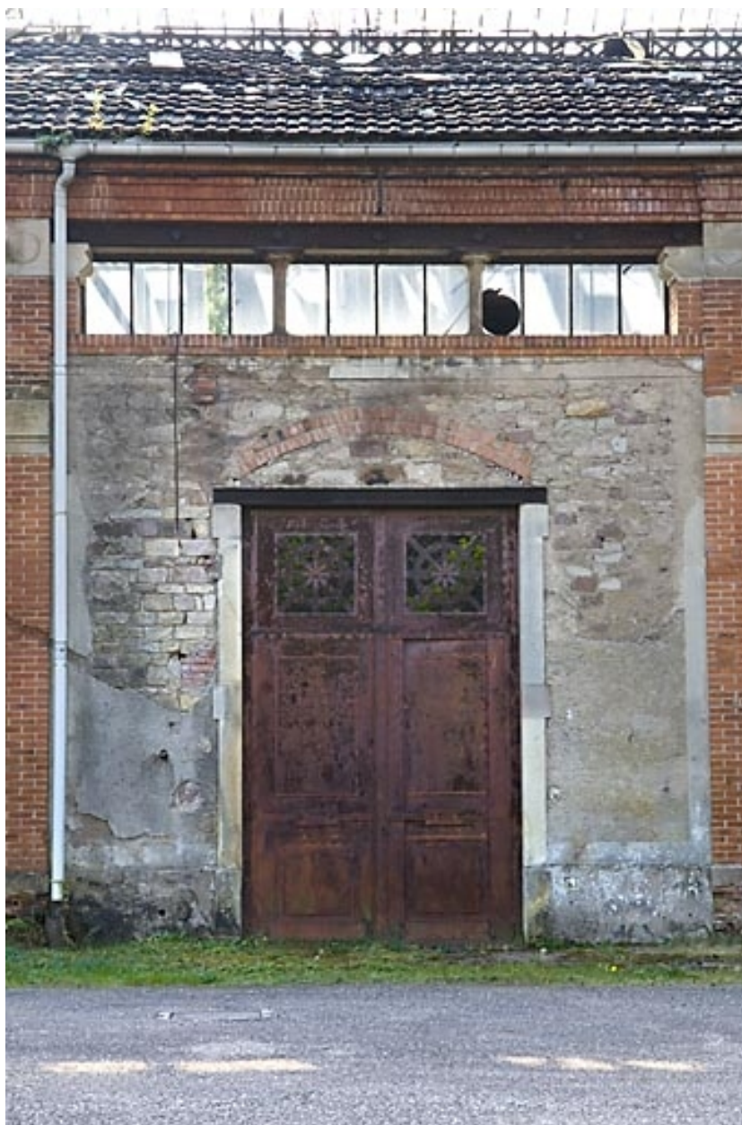
Façade antérieure. Détail d'une travée.
