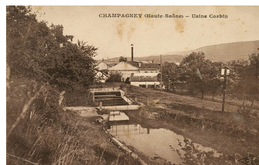
Champagny (Haute-Saône). Usine Corbin. Phot. Jérôme Mongreville IVR43_20067000180NUCA
