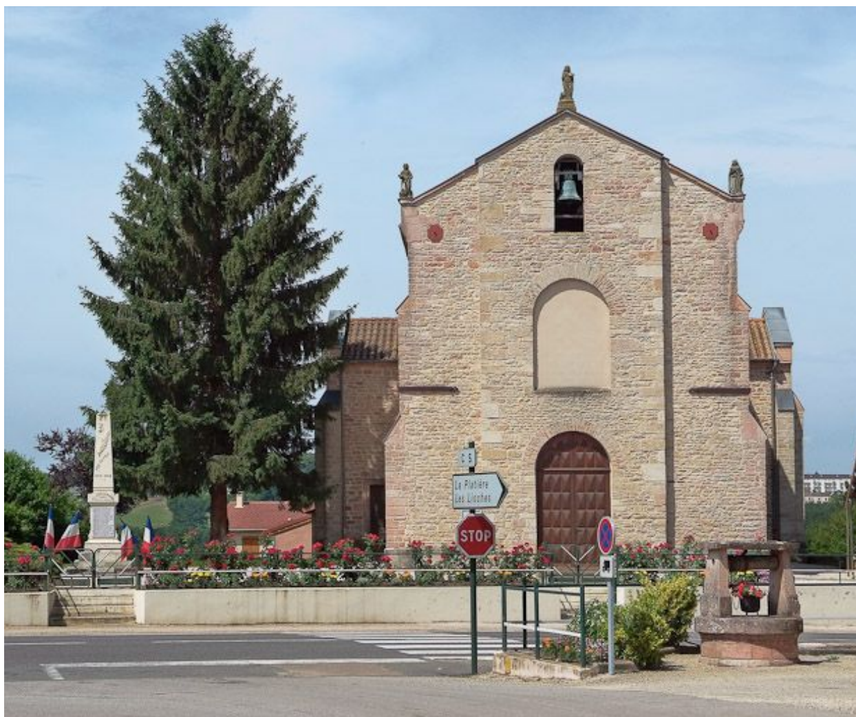
Vue d'ensemble de la façade.
