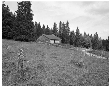
Vue de situation. Phot. Jérôme Mongreville IVR43_20003900513X
