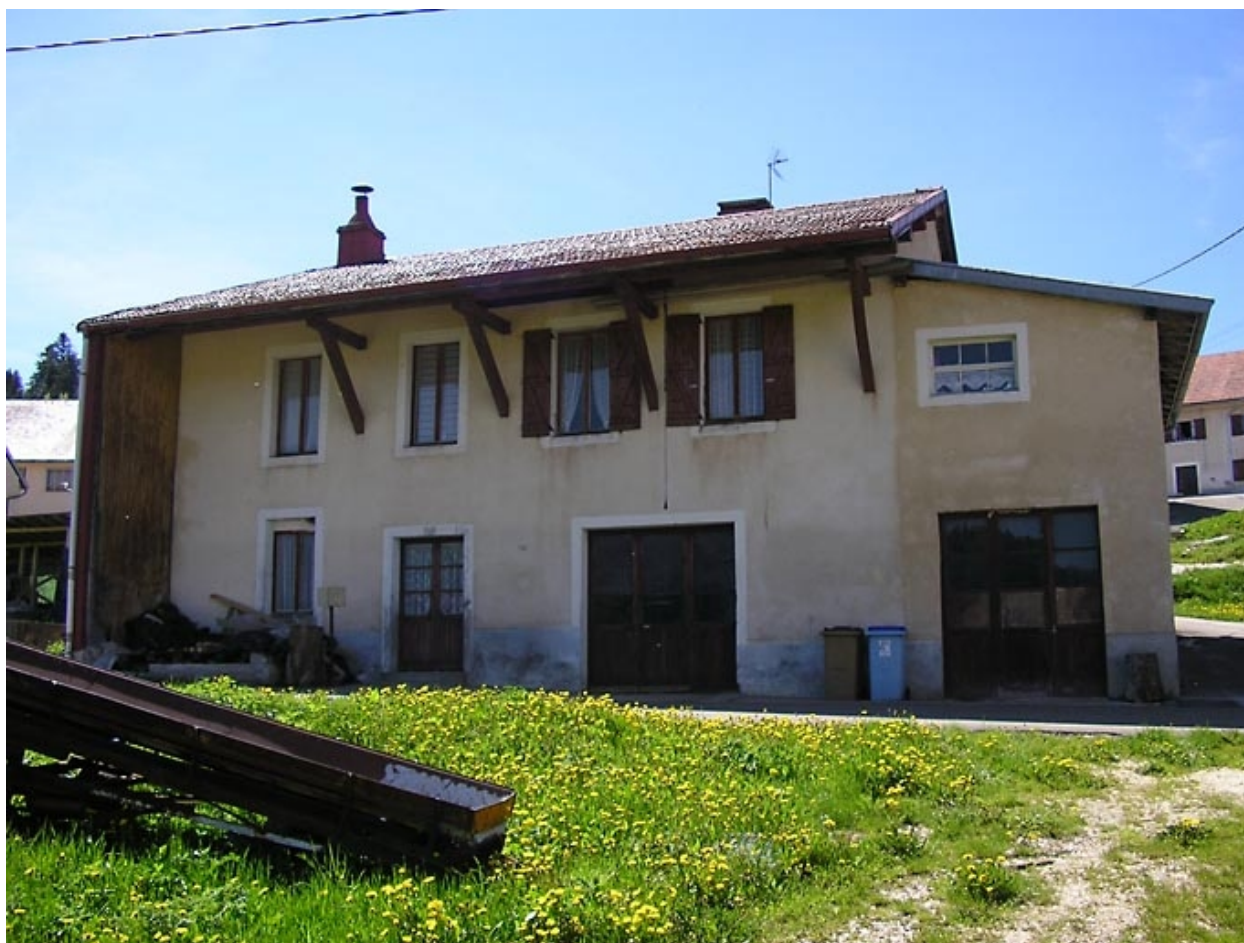
Vue latérale de la façade antérieure.
