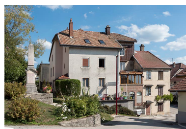
Vue d'ensemble sur la rue du Chêne. Phot. Sonia Dourlot IVR43_20192501240NUC4A
