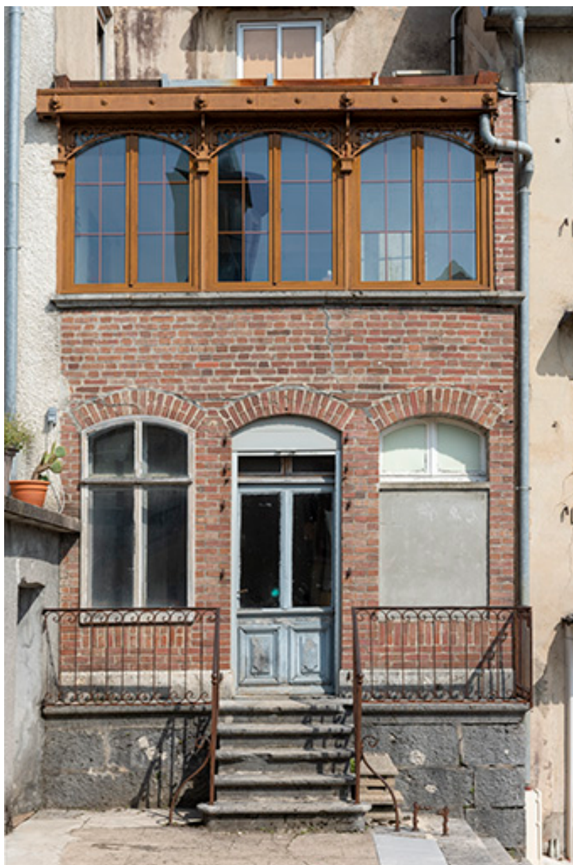
Magasin industriel rue du Chêne, de face.
