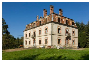
Vue d'ensemble. Phot. Sonia Dourlot IVR43_20157000683NUC2A
