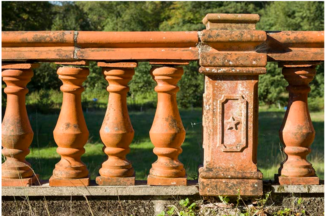
Balustrade de la terrasse, façade nord.
