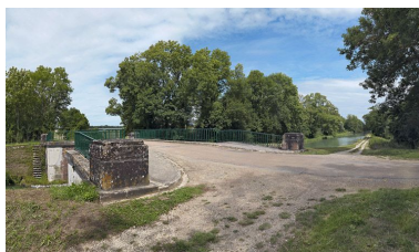
Vue du dessus. Phot. Thierry Kuntz IVR26_20118900141NUC4A
