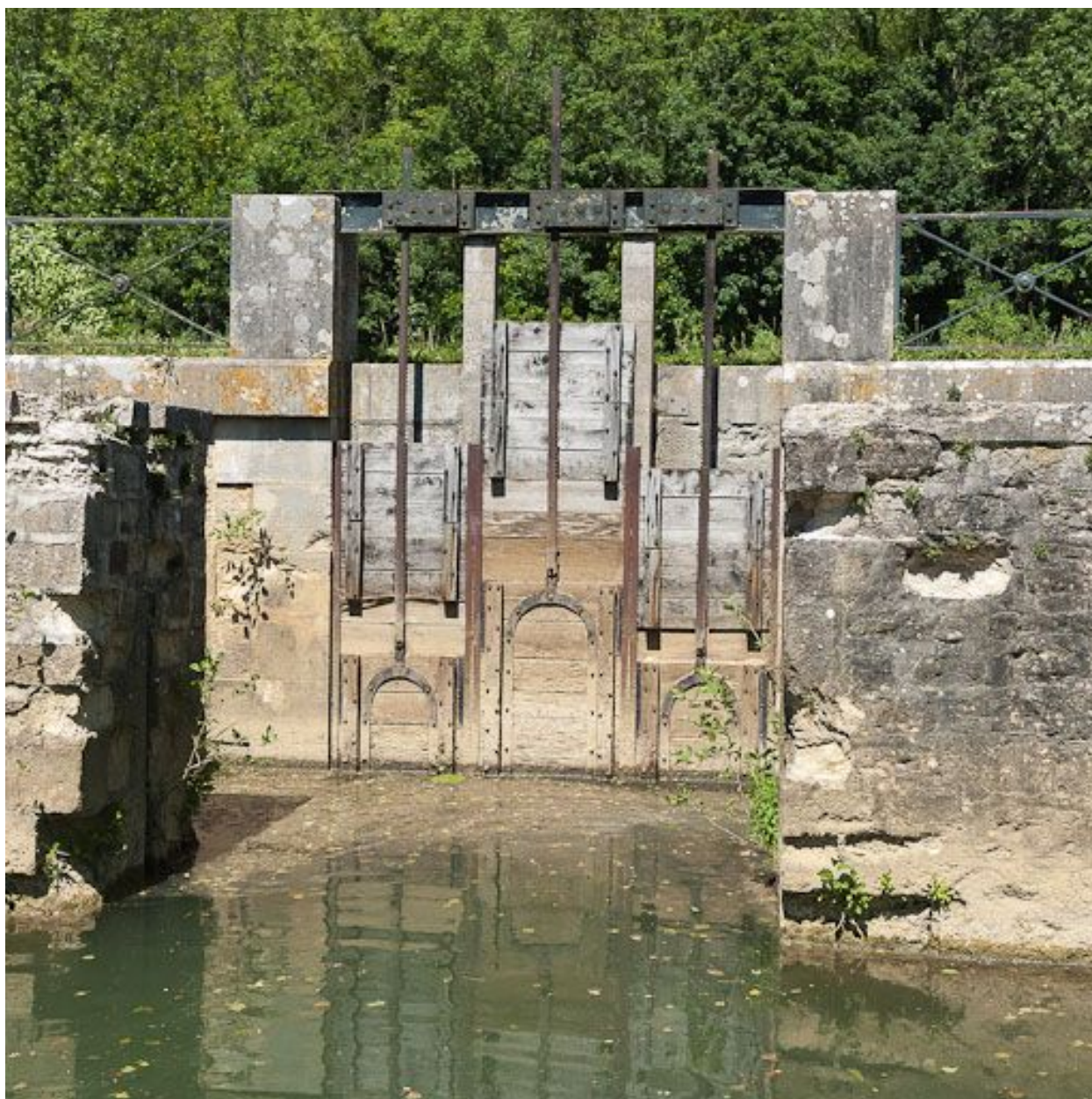
Détail des vannes en bois.
