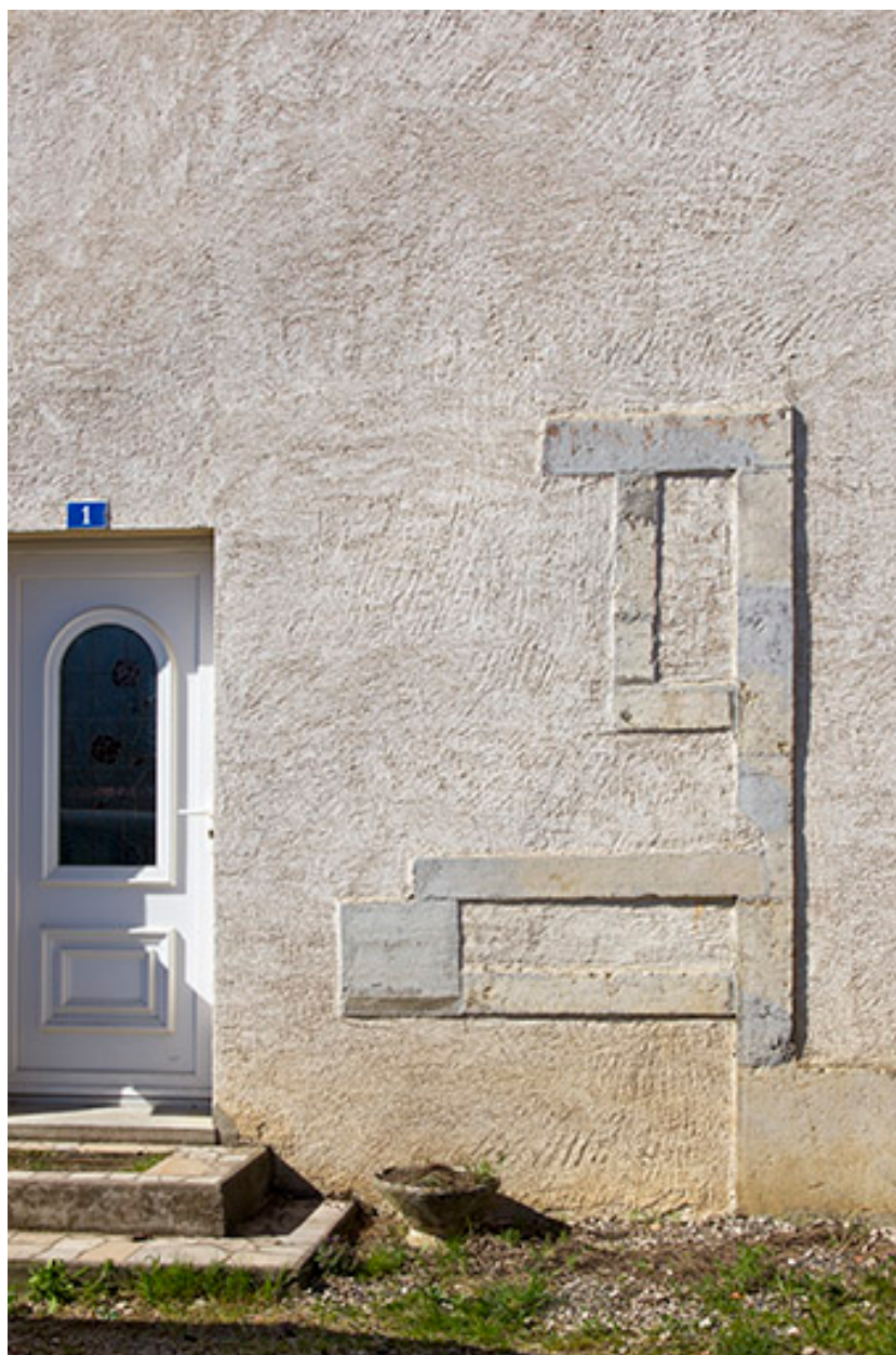
Façade postérieure : baies fromagères.
