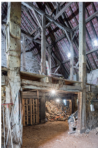
Détail des fermes de la charpente de la grange Phot. Jérôme Mongreville IVR43_20167001546NUC4A
