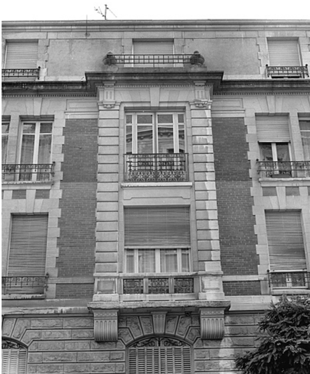
Façade antérieure, détail de l'élévation.
