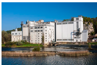
Façade sud depuis la rive gauche. Phot. Jérôme Mongreville IVR43_20142501587NUC4A
