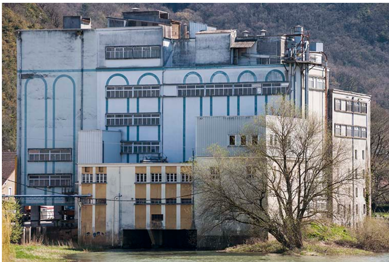
Vue rapprochée, depuis le sud-ouest.
