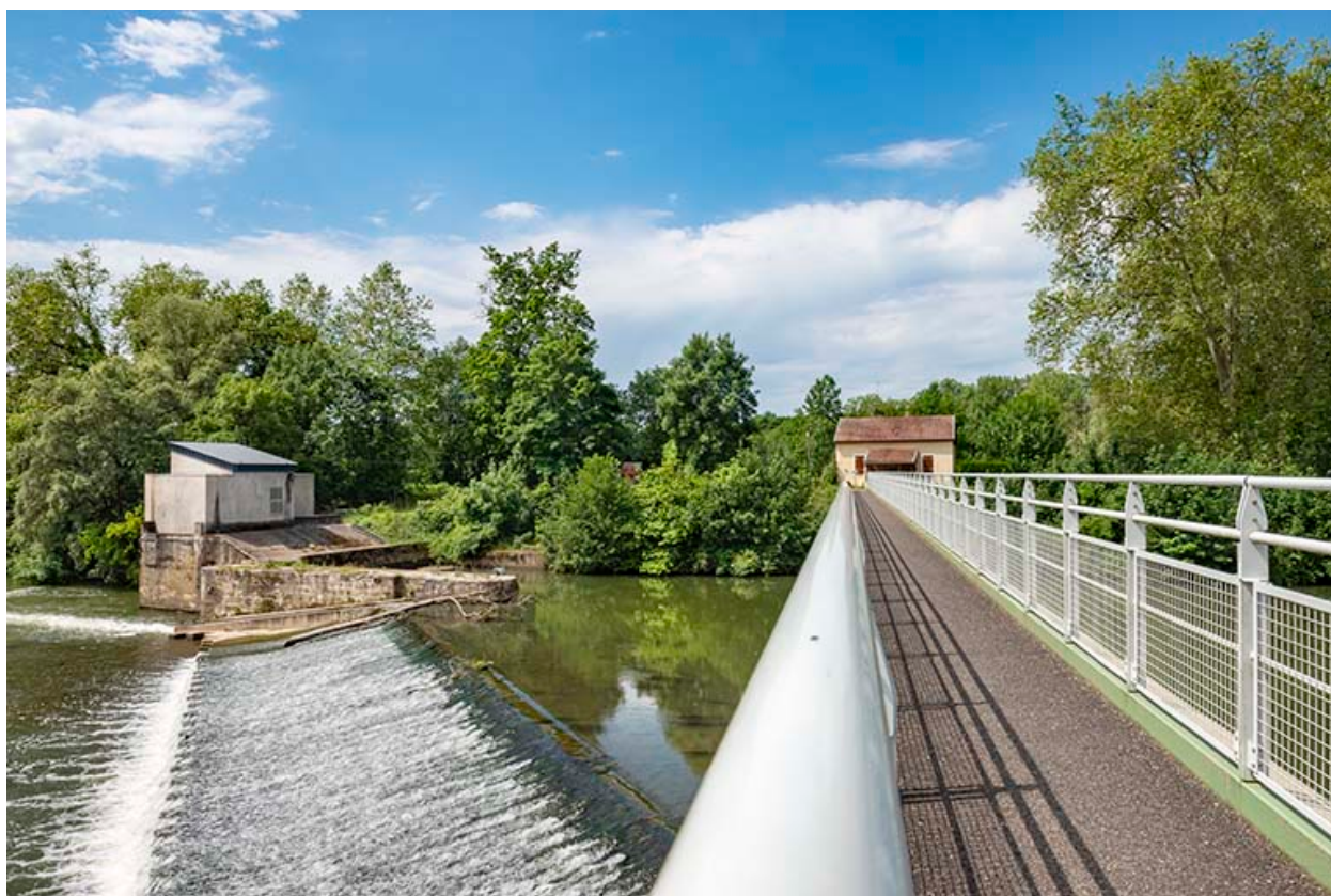
Barrage d'Apremont, vue depuis la passerelle.
