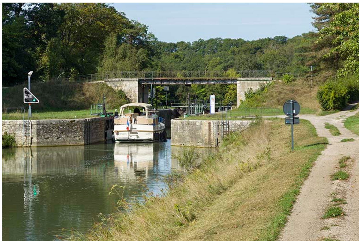
Bateau en amont de l'écluse à sas.
