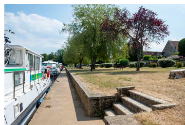
escalier d'accès au quai. Phot. Jérôme Mongreville IVR43_20207000233NUC4A
