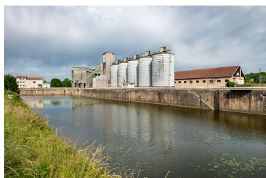
Bassin de l'ancienne gare fluviale. Phot. Sonia Dourlot IVR43_20197000376NUC4A
