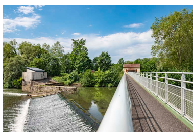
Barrage d'Apremont, vue depuis la passerelle. Phot. Jérôme Mongreville IVR43_20197000397NUC4A
