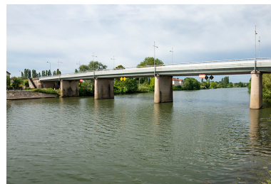
Le pont reconstruit après guerre. Phot. Jérôme Mongreville IVR43_20197000375NUC4A
