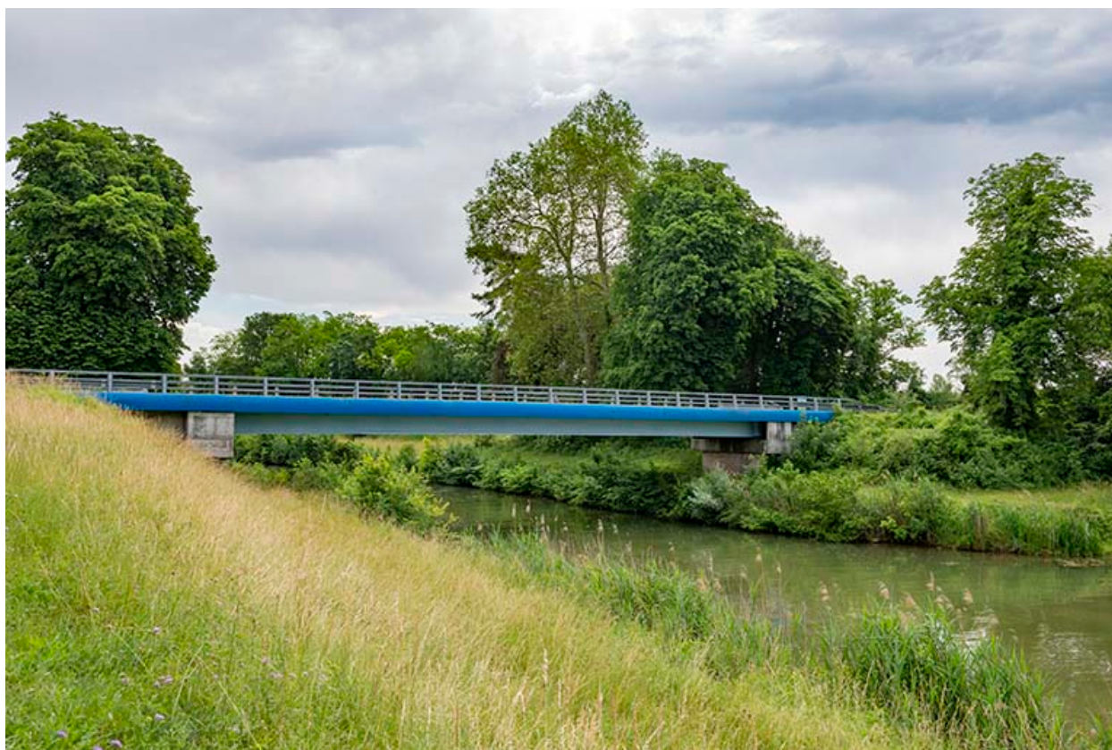
Pont routier enjambeant la dérivation.
