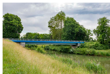
Pont routier enjambeant la dérivation. Phot. Jérôme Mongreville IVR43_20197000389NUC4A
