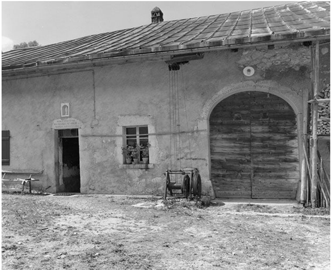
Les baies de la façade antérieure.
