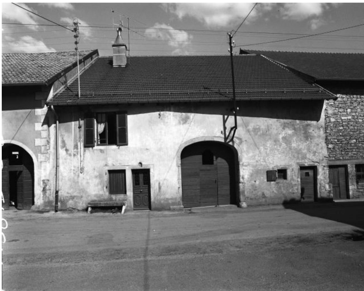
Façade antérieure de face.
