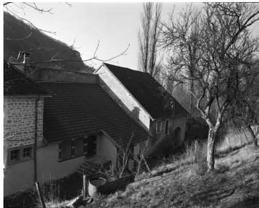
Aile nord. Logement et ferme. Phot. Jérôme Mongreville IVR43_19963900028X
