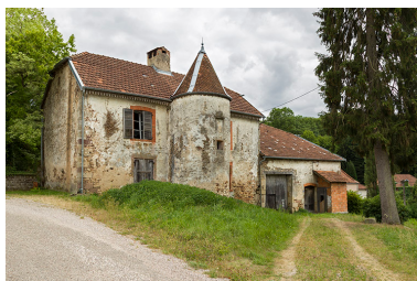
Vue générale de la maison Thysac. Phot. Sonia Dourlot IVR43_20157000704NUC2A
