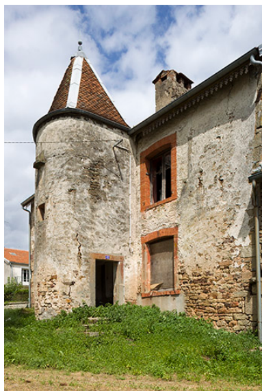
Vue sur la tourelle d'escalier. Phot. Sonia Dourlot IVR43_20157000706NUC2A
