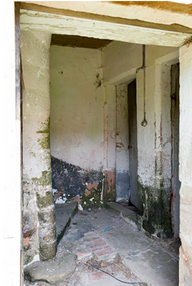
Bas de l'escalier à vis, maison Thysac. Phot. Sonia Dourlot IVR43_20157000707NUC2A
