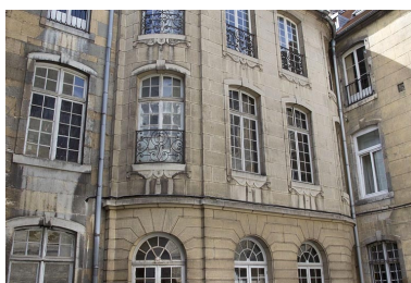
Aile de l'escalier : détail du premier étage. Phot. Yves Sancey IVR43_20112502787NUC2A
