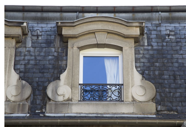
Logis secondaire : détail d'une lucarne. Phot. Yves Sancey IVR43_20112502777NUC2A
