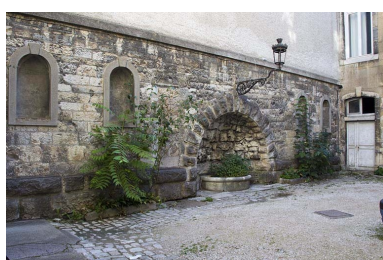
Mur gauche de la cour : vue d'ensemble. Phot. Yves Sancey IVR43_20112502780NUC2A
