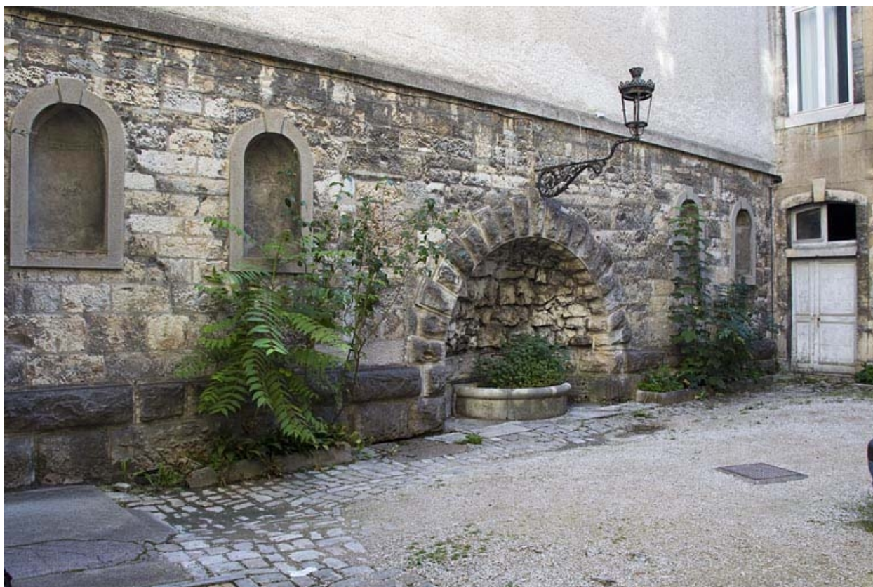
Mur gauche de la cour : vue d'ensemble.
