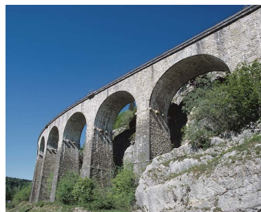
Extrémité côté La Cluse (nord-est). Phot. Yves Sancey IVR43_20053900341XA
