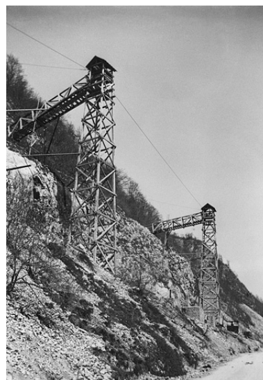
Travaux du chemin de fer : les pylônes pour la construction du viaduc des Crottes, 1899. Phot. Jérôme Mongreville, Autr. Luc Paget IVR43_19913900053X
