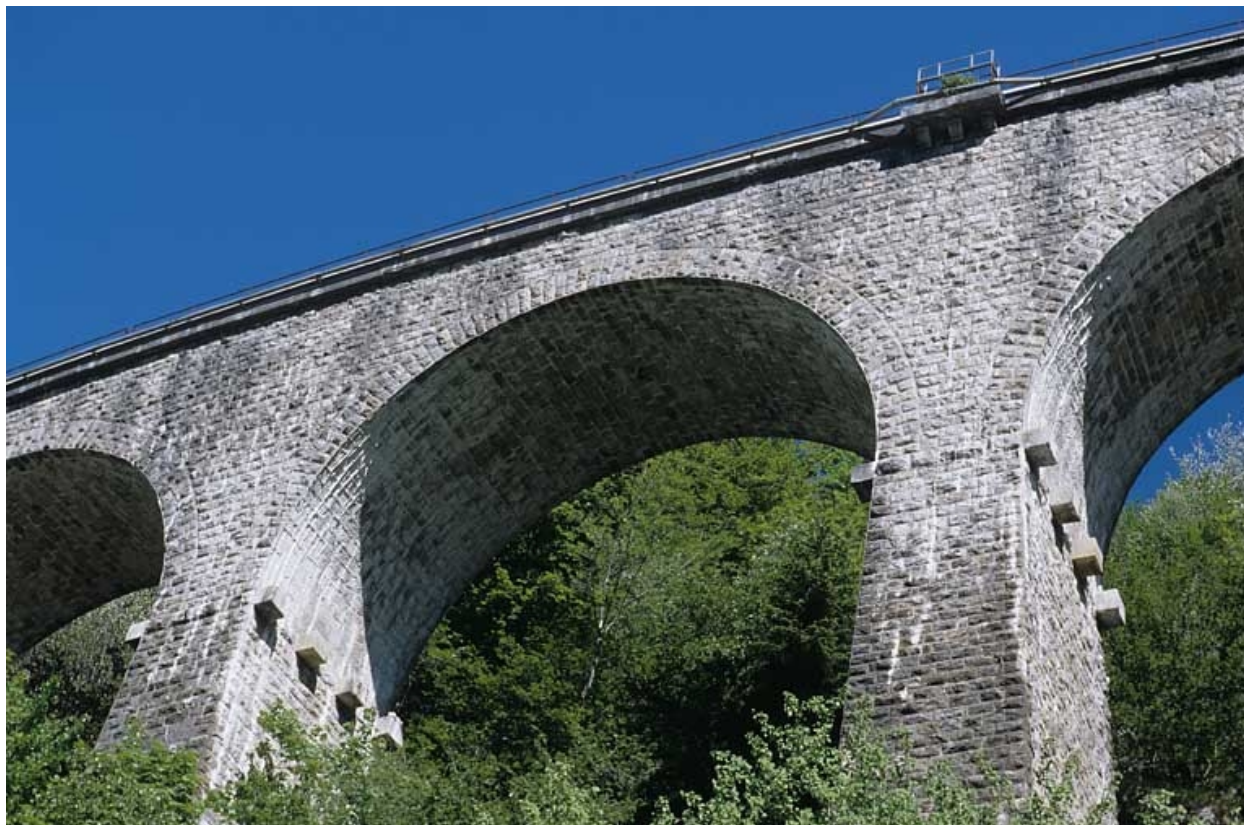
Une arche, vue en contre-plongée.
