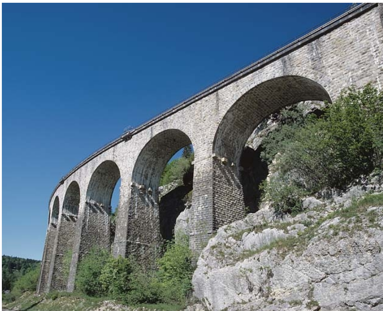
Extrémité côté La Cluse (nord-est).
