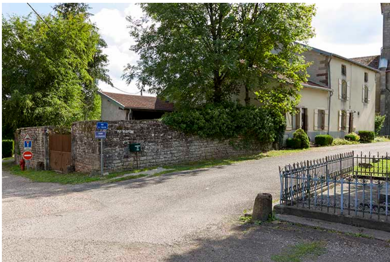
Vue d'ensemble depuis la Grande rue.
