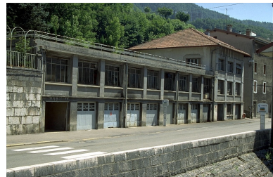
Atelier sur rue. Phot. Laurent Poupard IVR43_19913901523ZA
