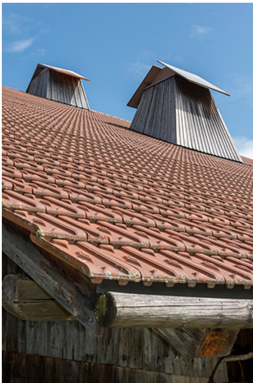
Pan de toiture sud, avec deux "tués".
