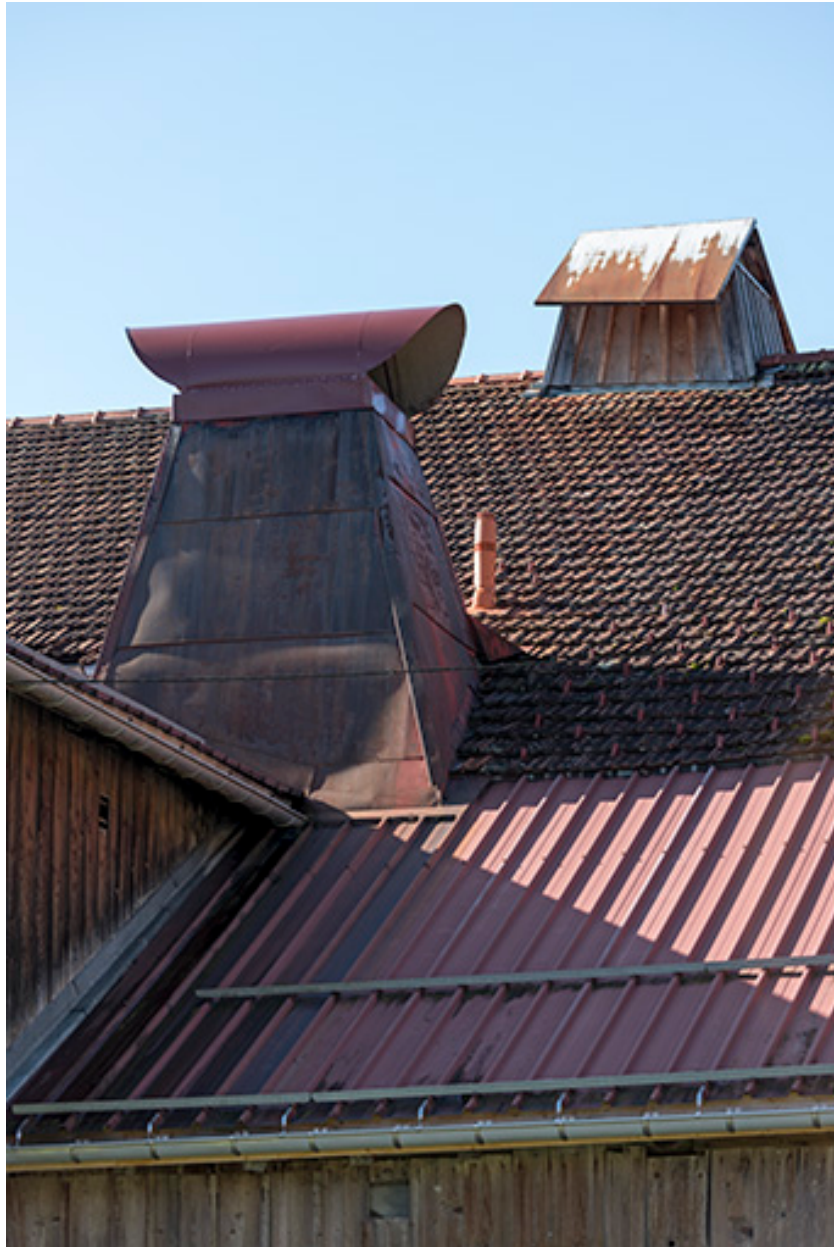
Pan de toiture nord, avec deux "tués".
