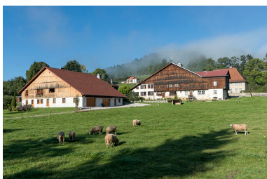
Vue d'ensemble éloignée, depuis l'est. Phot. Sonia Dourlot IVR43_20172501608NUC4A
