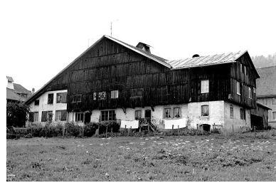
Façade est en 1976, de trois quarts droite. Phot. Dominique Humbert IVR43_19762500654X
