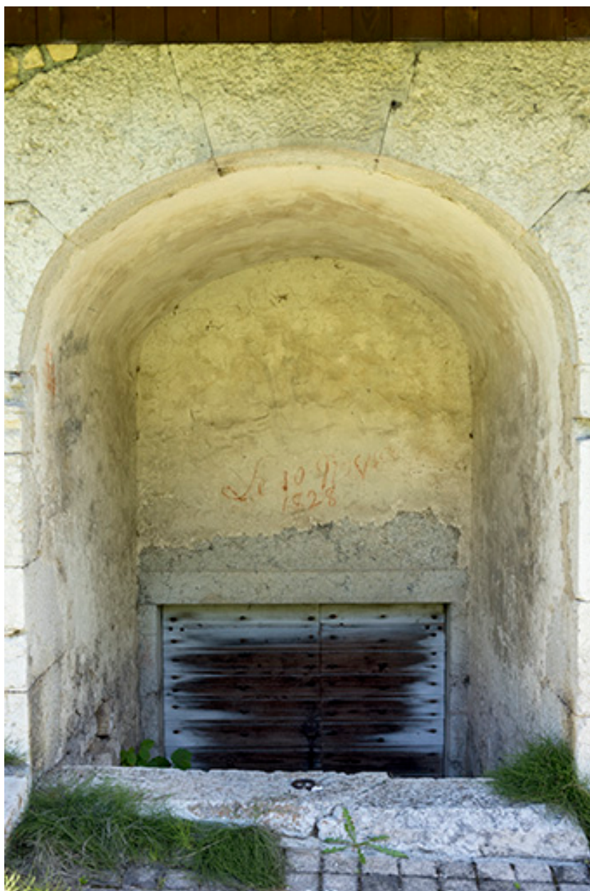
Façade sud : descente de cave et inscriptions.
