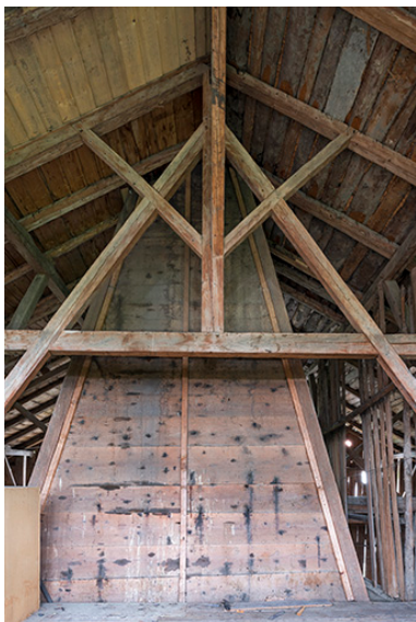
Intérieur, grange : hotte du "tué" central et charpente. Phot. Sonia Dourlot IVR43_20172500834NUC4A
