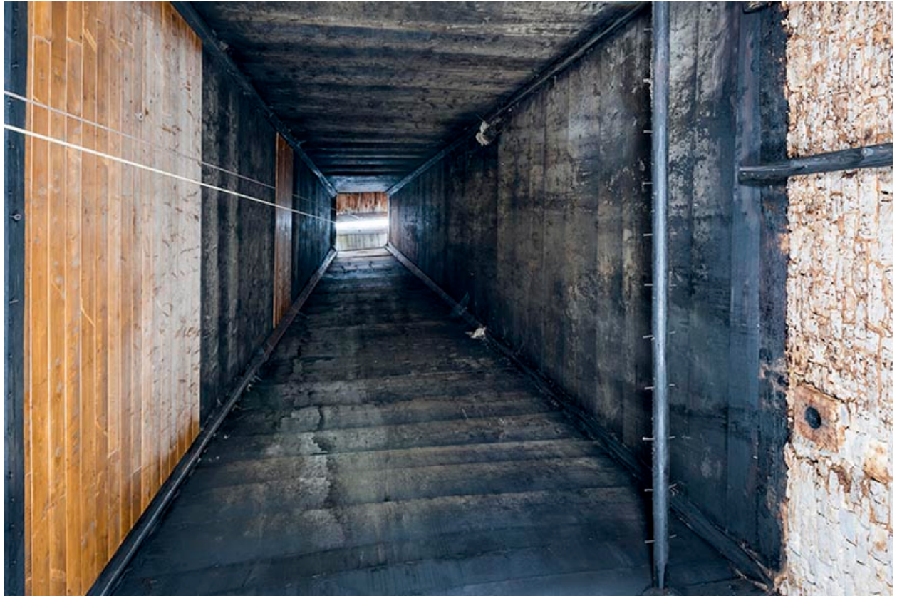
Intérieur, "tué" central : la hotte.
