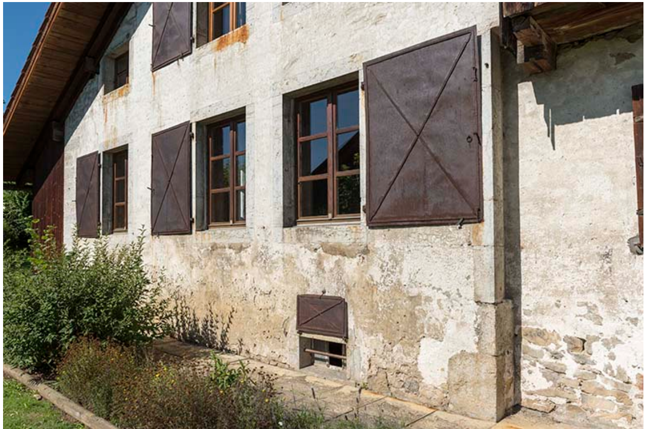
Corps sud-est et ses volets métalliques.
