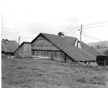
Façade ouest en 1976, de trois quarts droite. Phot. Dominique Humbert IVR43_19762500656X
