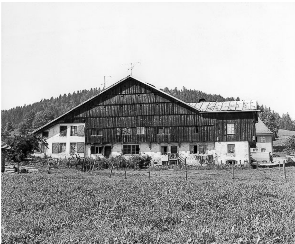
Façade est en 1976.
