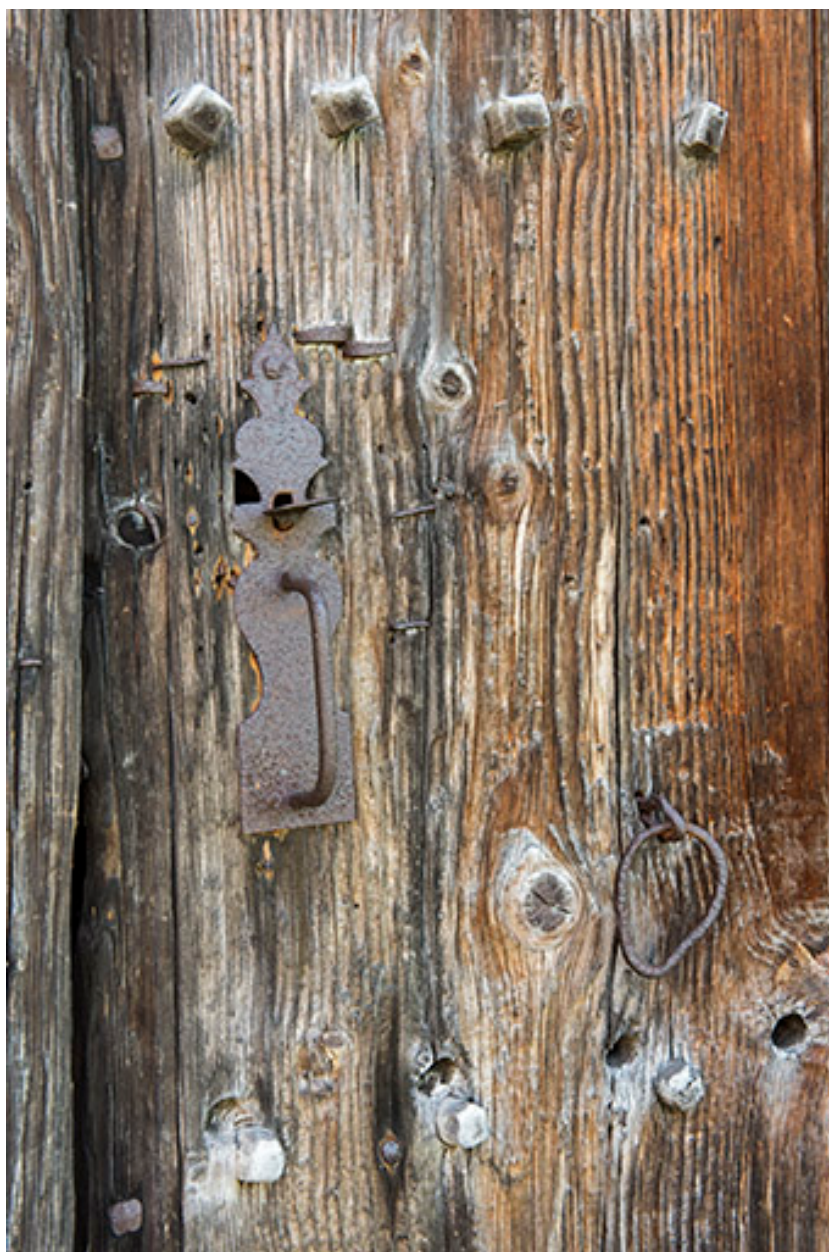
Façade ouest : détail d'une porte de grange.
