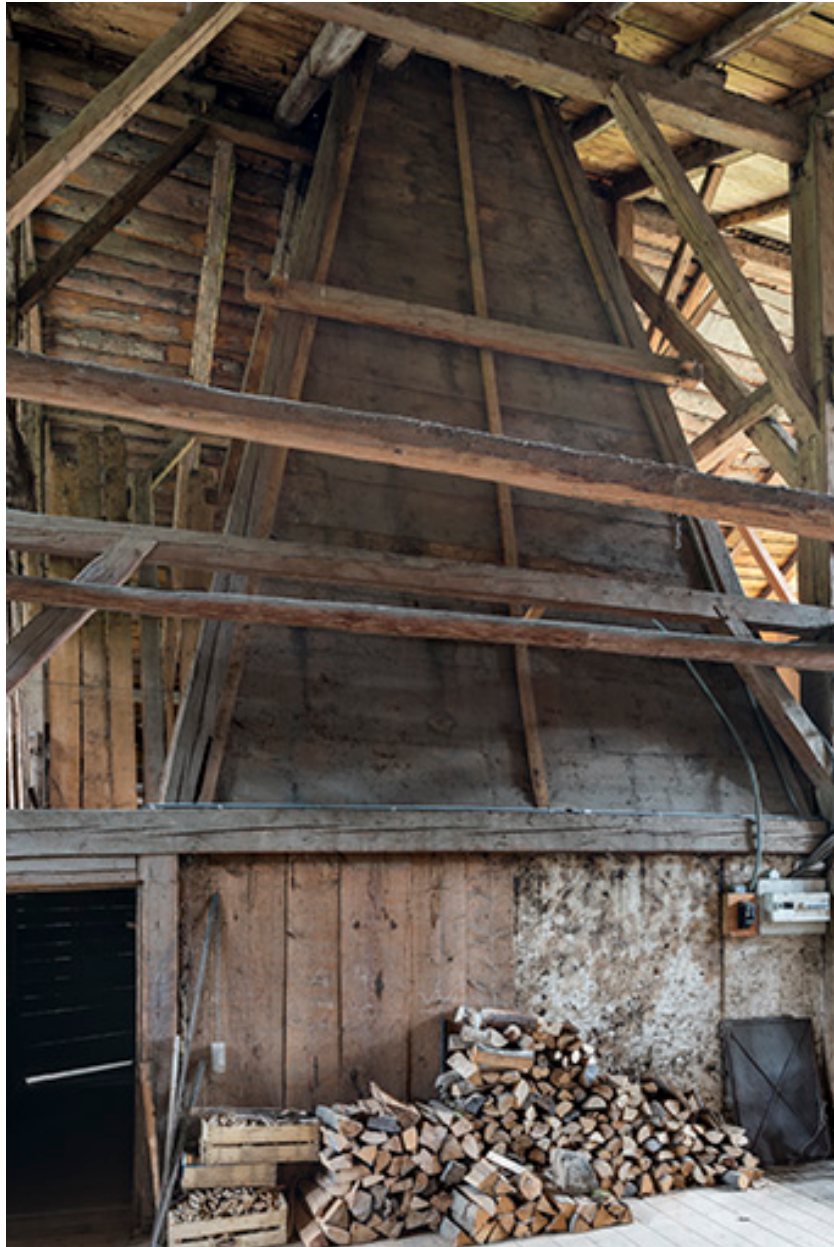
Intérieur, grange : hotte du "tué" central.
