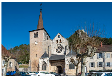
L'église et les bâtiments canoniaux vus depuis la place. Phot. Jérôme Mongreville IVR43_20213900040NUC4A
