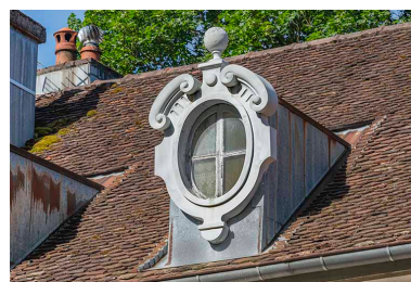
Maisons canoniales. Détail d'une lucarne. Phot. Jérôme Mongreville IVR43_20243900820NUC4A
