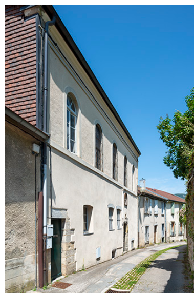
Maisons canoniales (4 à 8 rue des Claristes). Vue depuis le sud. Phot. Jérôme Mongreville IVR43_20233900740NUC4A
