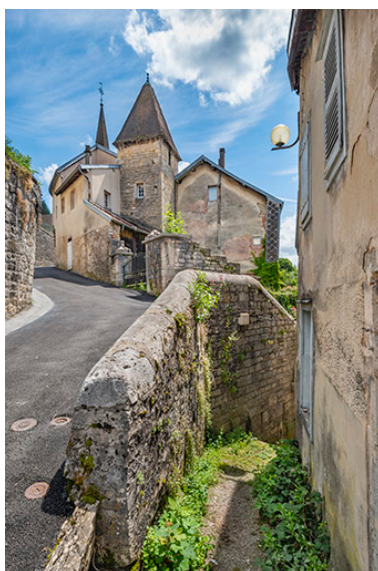
Maison canoniale (10 escaliers d'Arçon). Phot. Jérôme Mongreville IVR43_20243900717NUC4A
