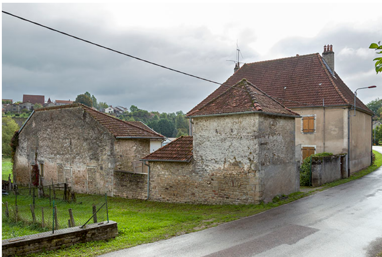
Vue d'ensemble depuis la rue du Presbytère.
