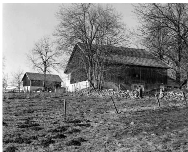
Ferme située au lieudit Combe Badier. Phot. Dominique Dominguez IVR43_19802500019X
