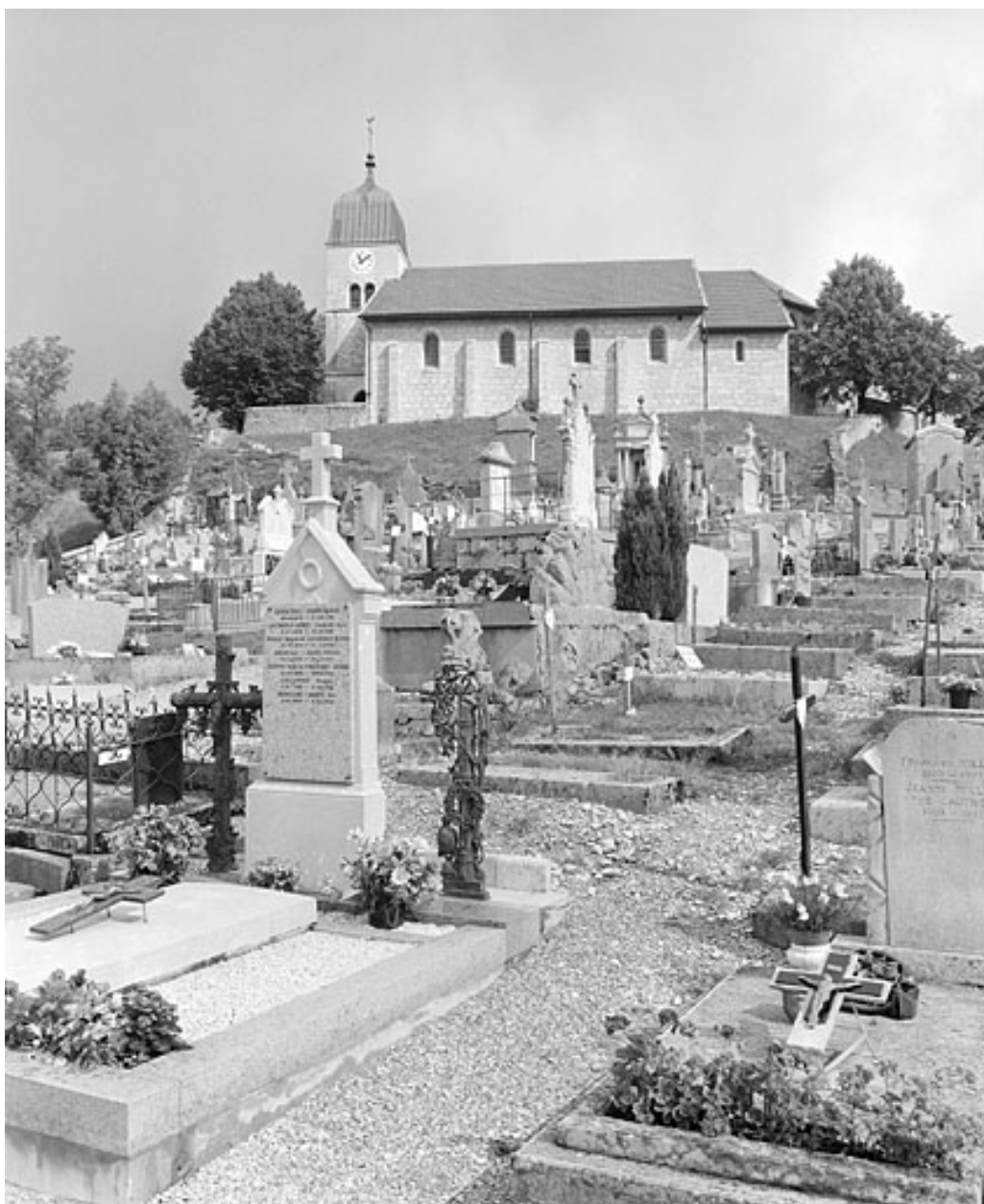
Face sud vue depuis le cimetière.
