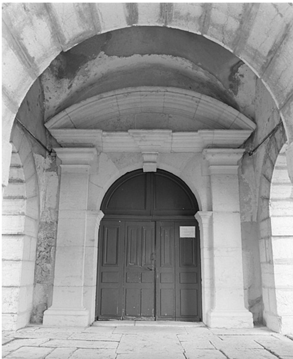
Le portail d'entrée de la nef.
