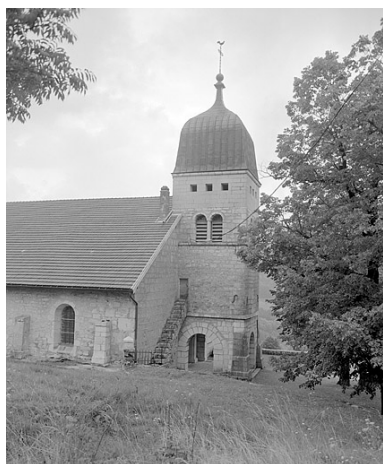
Face nord de la tour-clocher. Phot. Yves Sancey IVR43_19963900880X
