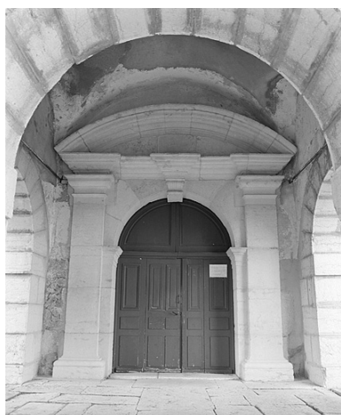
Le portail d'entrée de la nef. Phot. Yves Sancey IVR43_19963900883X
