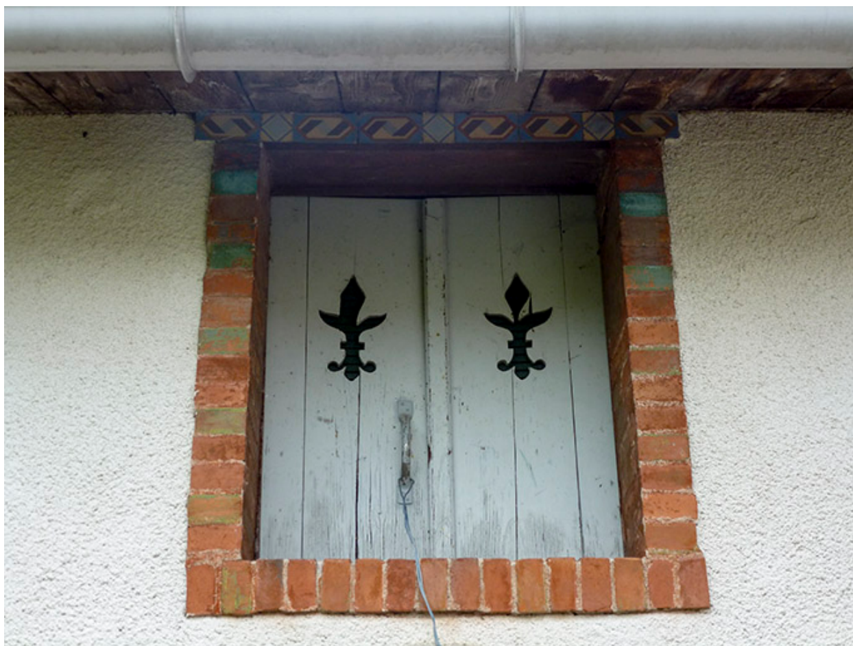
Remise : baie de l'étage de comble.
