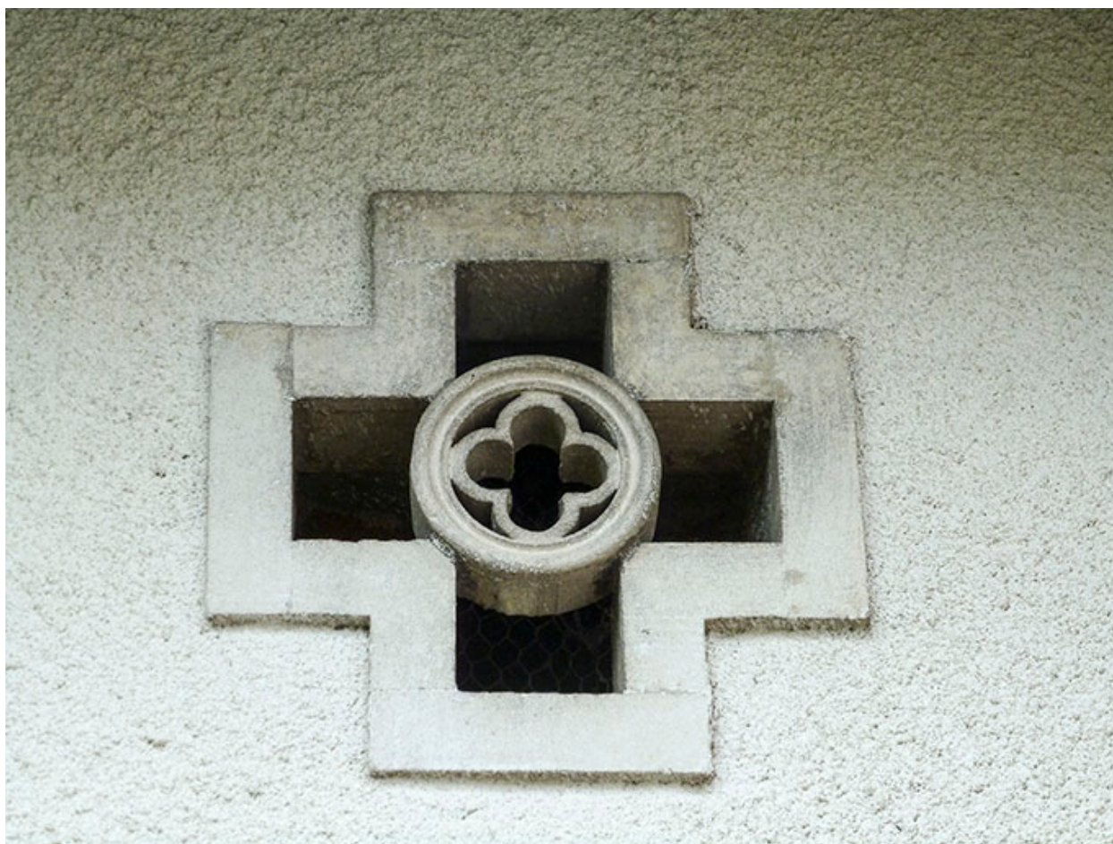
Remise : baie cruciforme de l'étage de comble.
