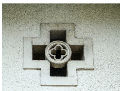
Remise : baie cruciforme de l'étage de comble. Phot. Jérôme Mongreville IVR43_20167000126NUC2A
