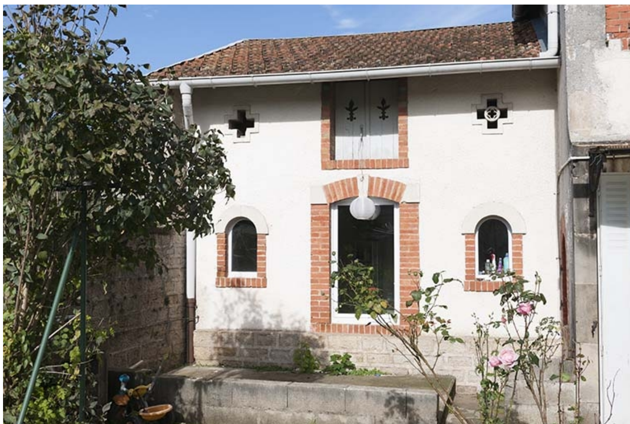
Façade antérieure de la remise.
