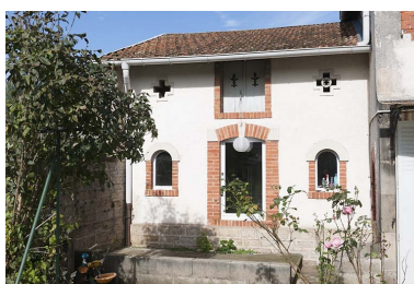
Façade antérieure de la remise. Phot. Jérôme Mongreville IVR43_20127000406NUC4A
