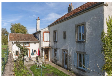
Façade postérieure et remise.
