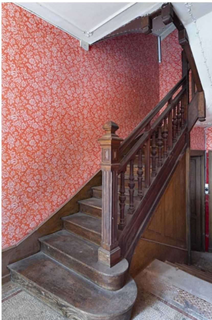
Escalier, vue depuis le palier du rez-de-chaussée.
