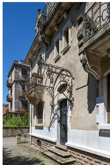
Porte d'entrée. Phot. Jérôme Mongreville IVR43_20207000554NUC4A
