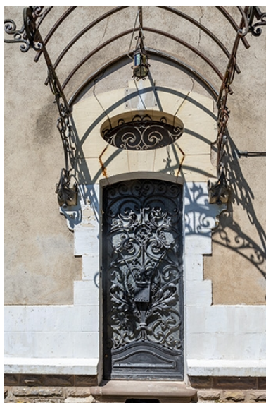
Porte d'entrée. Phot. Jérôme Mongreville IVR43_20207000562NUC4A
