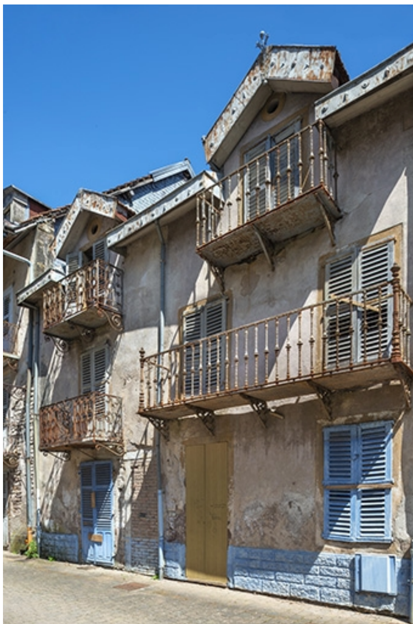
Balcons de l'ancienne maison.
