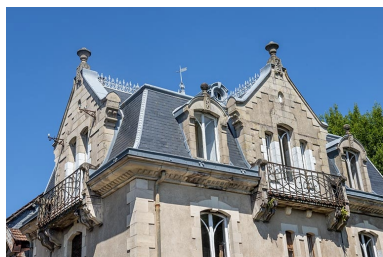
Toiture et lucarnes. Phot. Jérôme Mongreville IVR43_20207000565NUC4A
