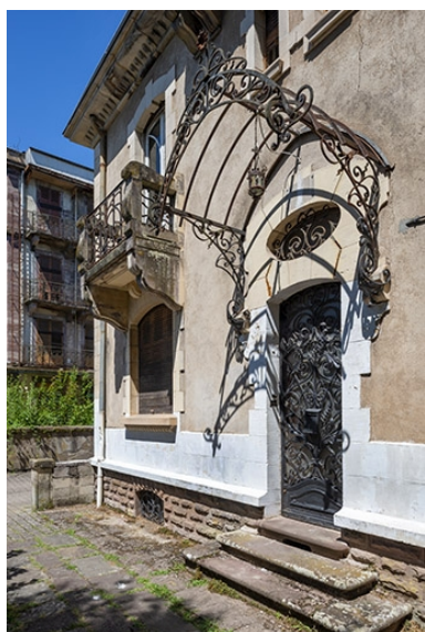
Porte d'entrée. Phot. Jérôme Mongreville IVR43_20207000555NUC4A
