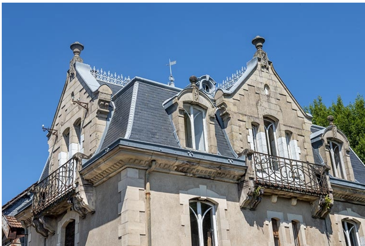
Toiture et lucarnes.
