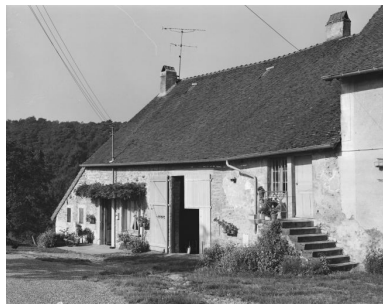
Façade antérieure. Phot. Dominique Dominguez IVR43_19803900120X
