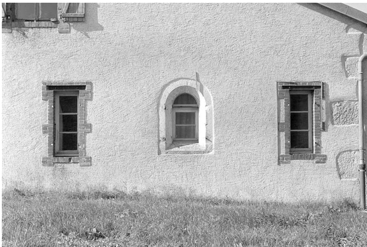
Détail des fenêtres de la fromagerie.
