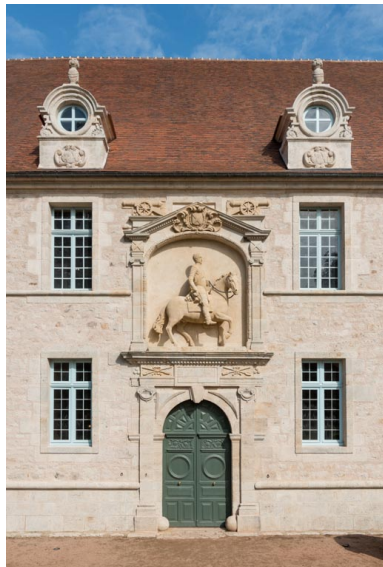
Façade sud-est, travée centrale, après restauration. Phot. Pierre-Marie Barbe-Richaud IVR26_20217100115NUC4A
