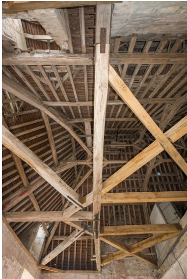
Charpente à chevrons portant-fermes, croupe sud-ouest, vue depuis le premier étage. Phot. Pierre-Marie Barbe-Richaud IVR26_20217100149NUC4A
