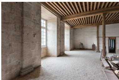
Premier étage. Phot. Pierre-Marie Barbe-Richaud IVR26_20217100152NUC4A
