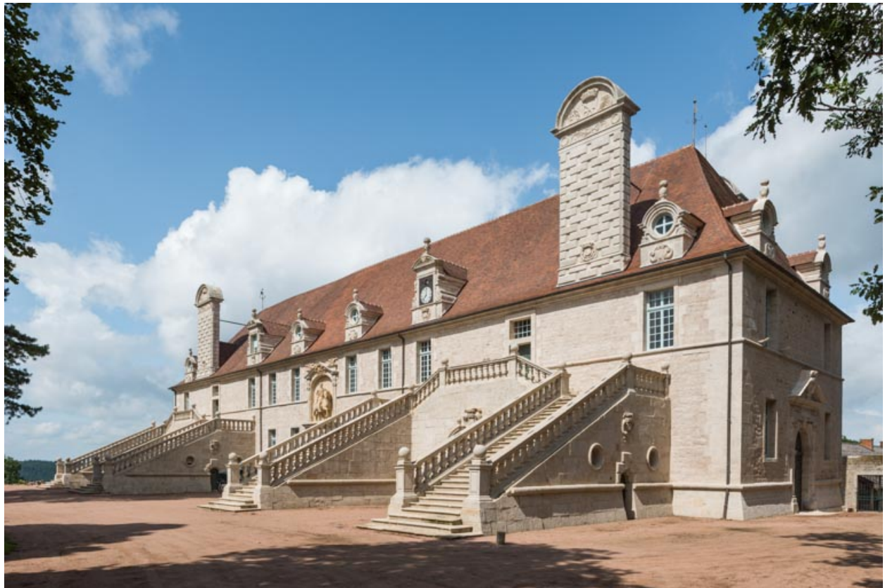
Façade sud-est, vue d'ensemble depuis l'est.
