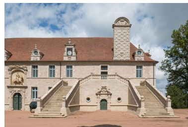
Façade sud-est, partie droite, grand-degré. Phot. Pierre-Marie Barbe-Richaud IVR26_20217100132NUC4A
