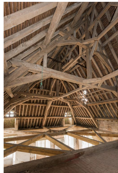
Charpente à chevrons portant-fermes, croupe sud-ouest, vue depuis l'étage de comble. Phot. Pierre-Marie Barbe-Richaud IVR26_20217100150NUC4A
