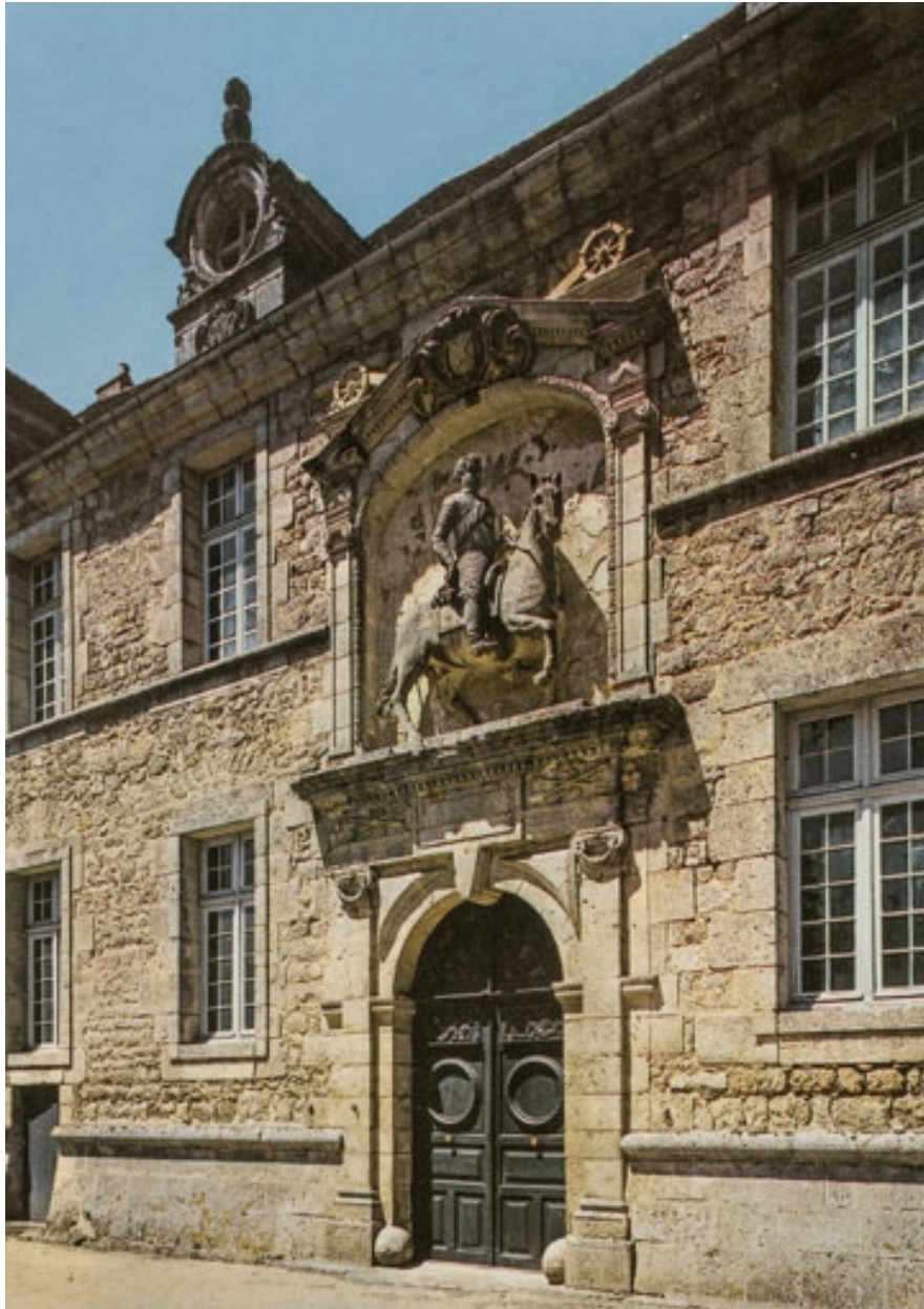
Façade sud-est, travée centrale, avant restauration.
