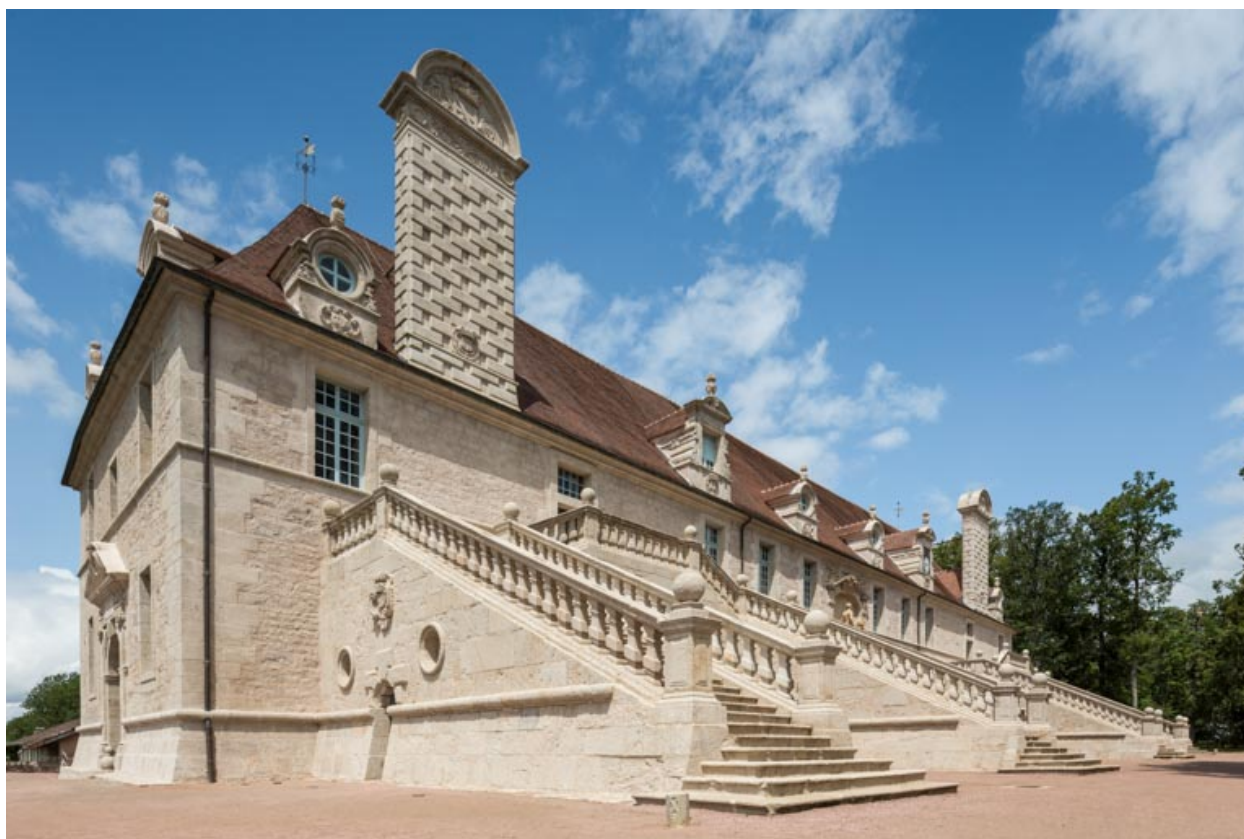
Façade sud-est, vue d'ensemble depuis le sud.
