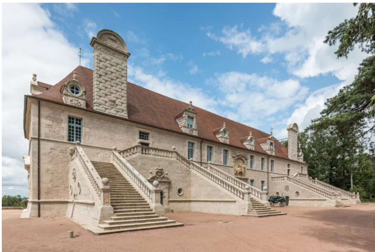
Façade sud-est, vue d'ensemble depuis le sud.
