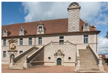
Façade sud-est, partie droite, grand-degré. Phot. Pierre-Marie Barbe-Richaud IVR26_20217100131NUC4A
