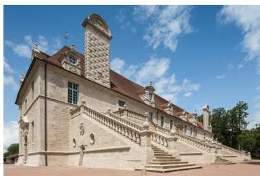
Façade sud-est, vue d'ensemble depuis le sud. Phot. Pierre-Marie Barbe-Richaud IVR26_20217100136NUC4A
