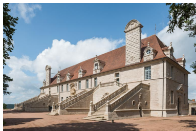
Façade sud-est, vue d'ensemble depuis l'est. Phot. Pierre-Marie Barbe-Richaud IVR26_20217100130NUC4A
