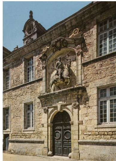
Façade sud-est, travée centrale, avant restauration. Autr. auteur inconnu IVR26_20217100329NUC4A
