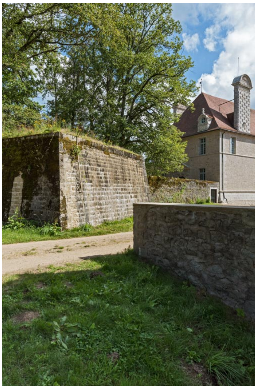
Mur d'enceinte, vue depuis le nord.
