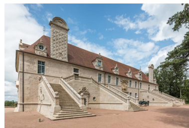
Façade sud-est, vue d'ensemble depuis le sud. Phot. Pierre-Marie Barbe-Richaud IVR26_20217100135NUC4A
