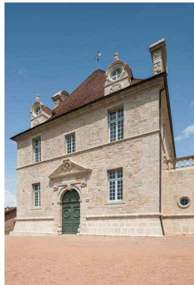
Façade sud-ouest. Phot. Pierre-Marie Barbe-Richaud IVR26_20217100137NUC4A
