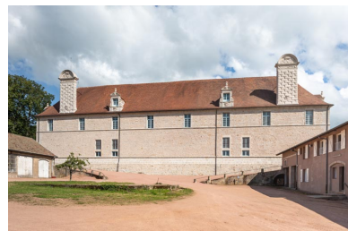
Façade nord-ouest. Phot. Pierre-Marie Barbe-Richaud IVR26_20217100147NUC4A
