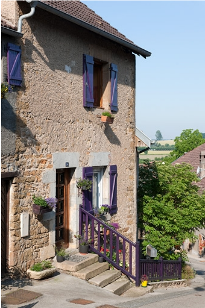
Maison au 14 rue des Gratteris (2010 AK 111).
