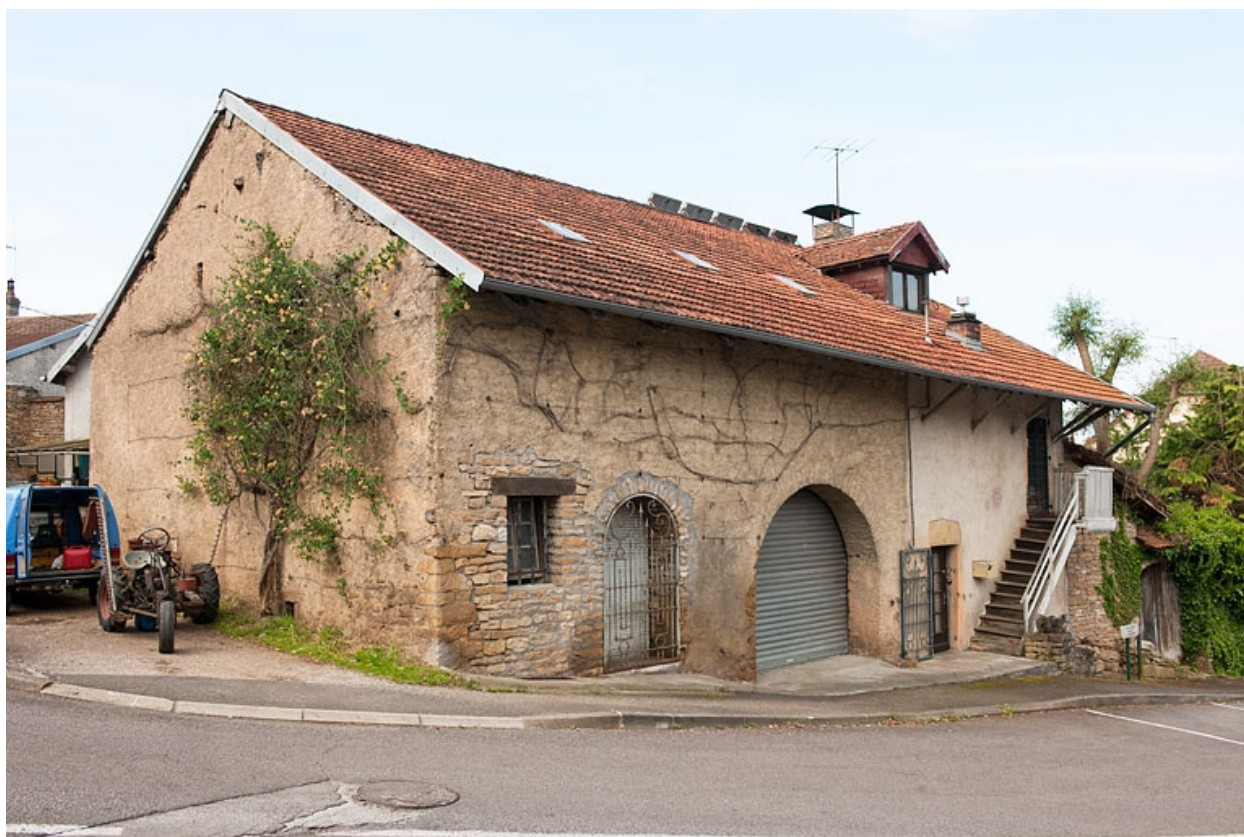
Ferme au 2 rue Maurice Demeusy (2010 AL 416).
