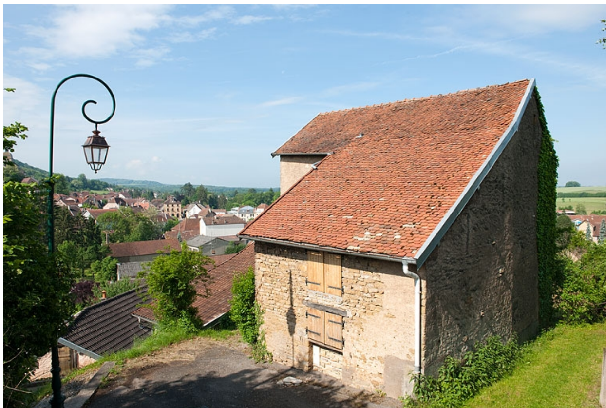
Maison au 3 rue de l'Ancien Cimetière (2010 AK 107).
