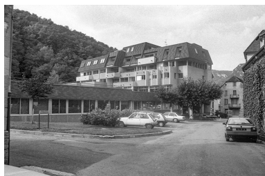
Vue d'ensemble depuis le sud de la rue des Barres, s.d. [vers 1985]. Phot. Georges Chenu IVR43_20243901195NUC4A
