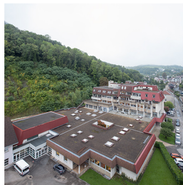
Vue plongeante depuis le sud. Phot. Nicolas Waltefaugle IVR43_20253900264NUC4A
