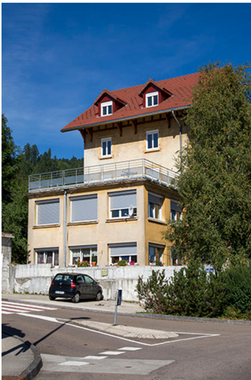
Façade latérale gauche, de trois quarts droite.
