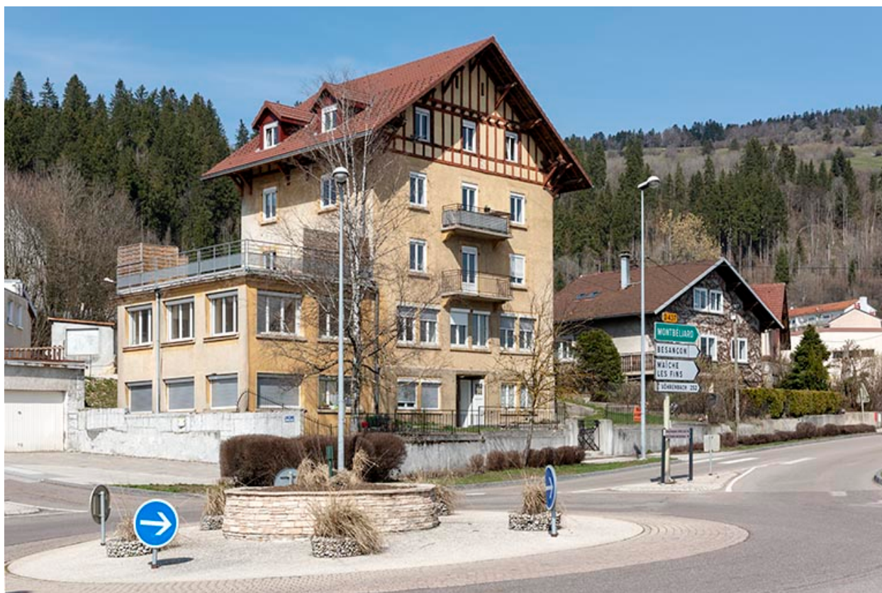
Façades antérieure et latérale gauche, en hiver.
