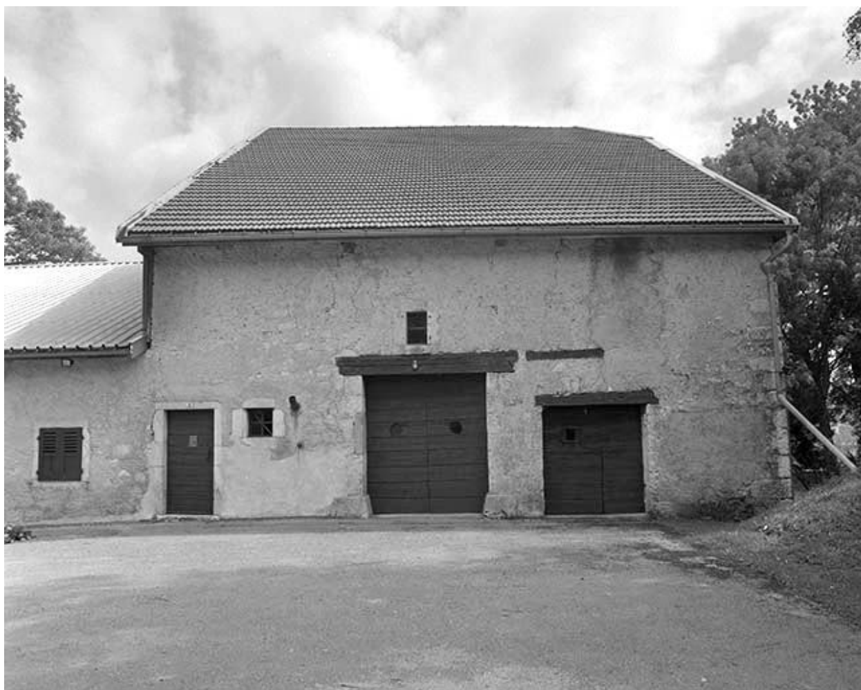
Façade postérieure de la ferme de gauche.
