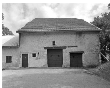
Façade postérieure de la ferme de gauche. Phot. Jérôme Mongreville IVR43_20003900443X
