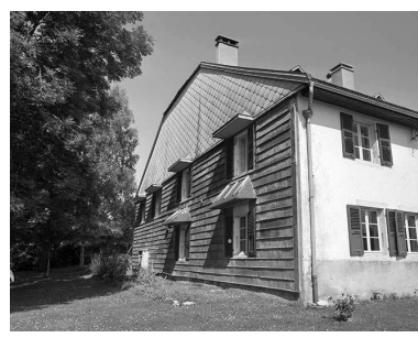
Face gauche vue de trois quarts. Phot. Jérôme Mongreville IVR43_20003900439X
