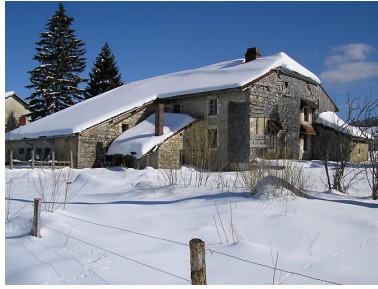
Façade postérieure. Phot. Marie-Pierre Reynet IVR43_20083900226NUC1A
