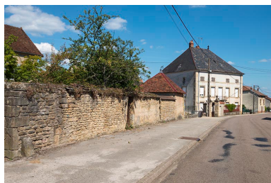
Vue depuis la voie publique. Phot. Jérôme Mongreville IVR43_20177001305NUC4A
