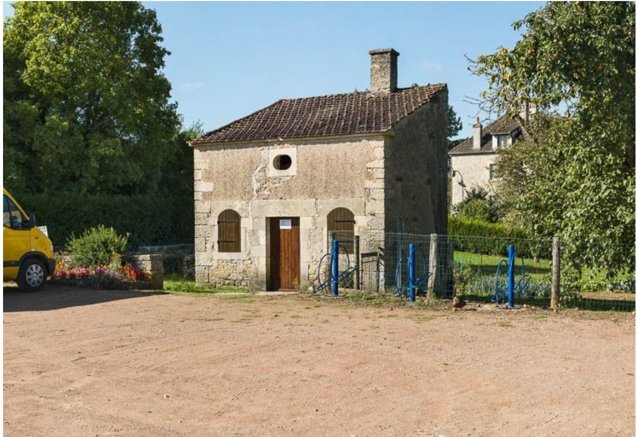
L'abri des ouvriers : vue de 3/4.
