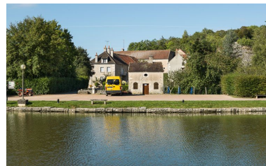
L'abri des ouvriers : vue de face. Phot. Pierre-Marie Barbe-Richaud IVR26_20135800453NUC4AQ
