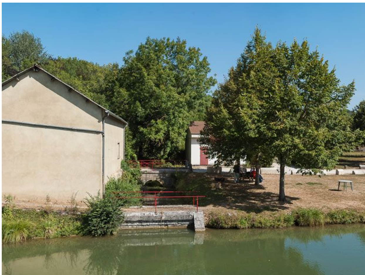
Détail d'un déversoir en aval du port.
