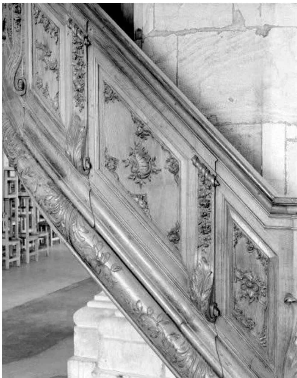
Détail : panneau de la rampe.
