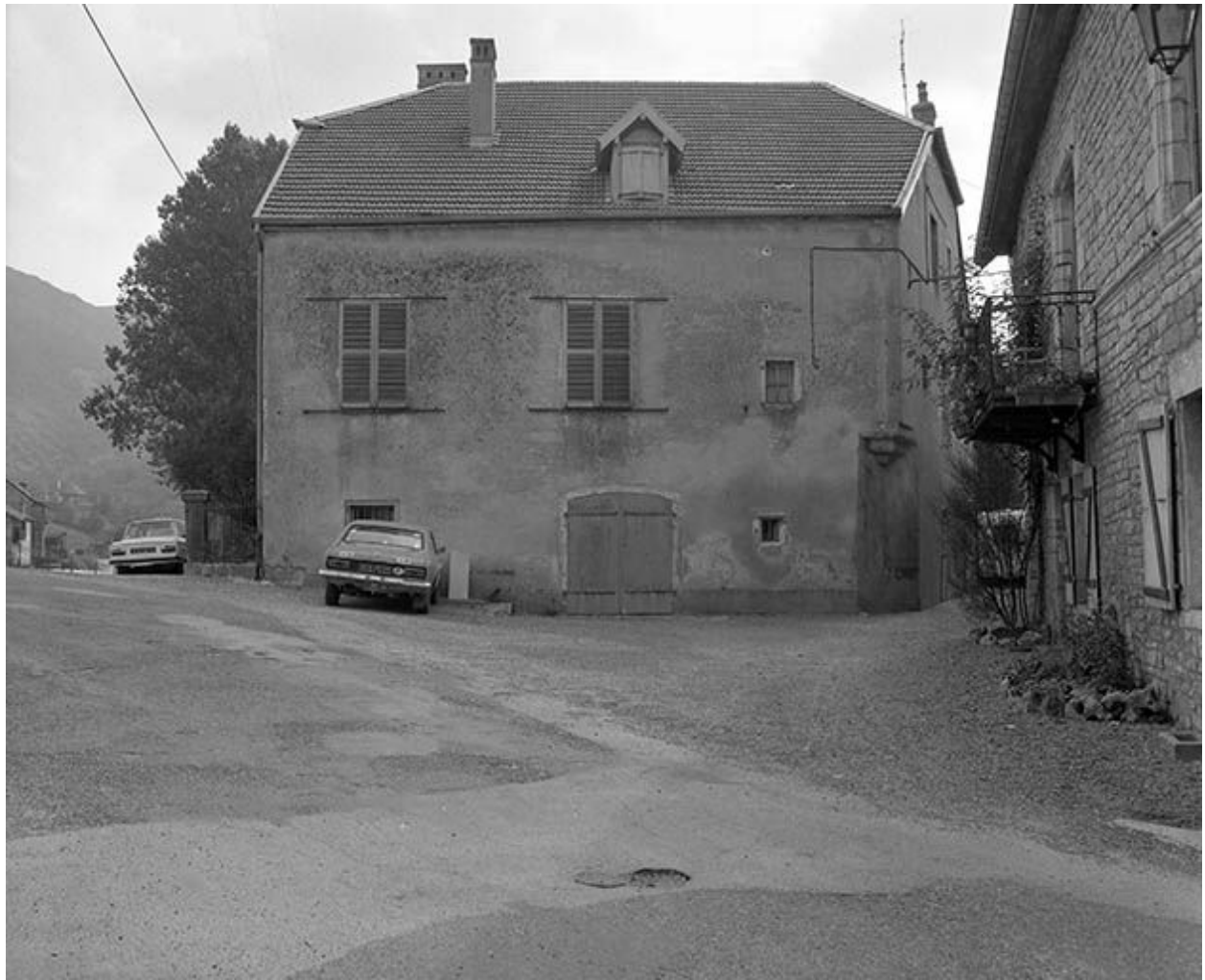
Façade latérale droite.
