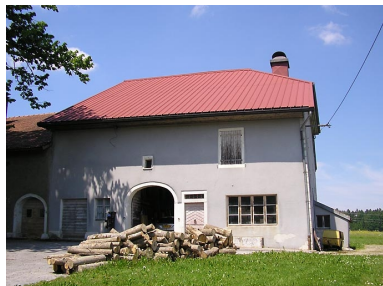
Vue de la façade antérieure. Phot. Marie-Pierre Reynet IVR43_20083900002NUC1A
