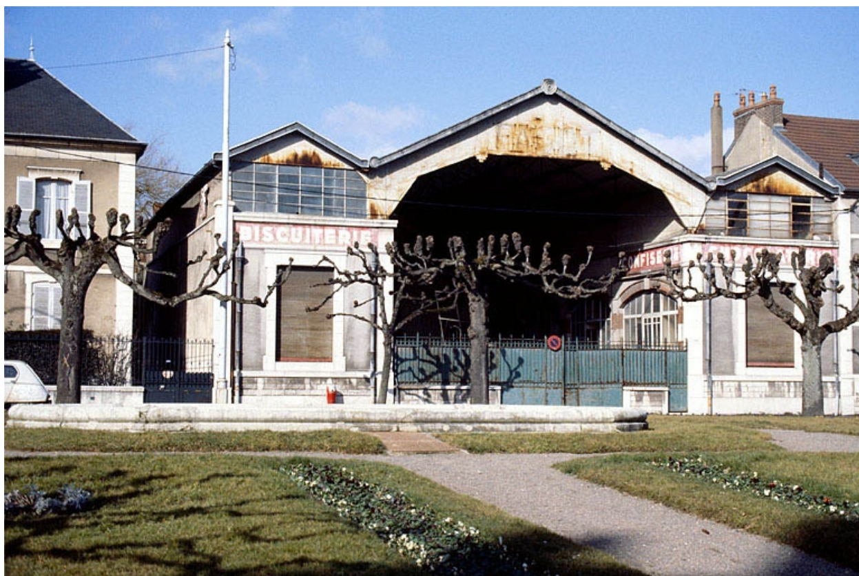
Façade antérieure de l'usine.
