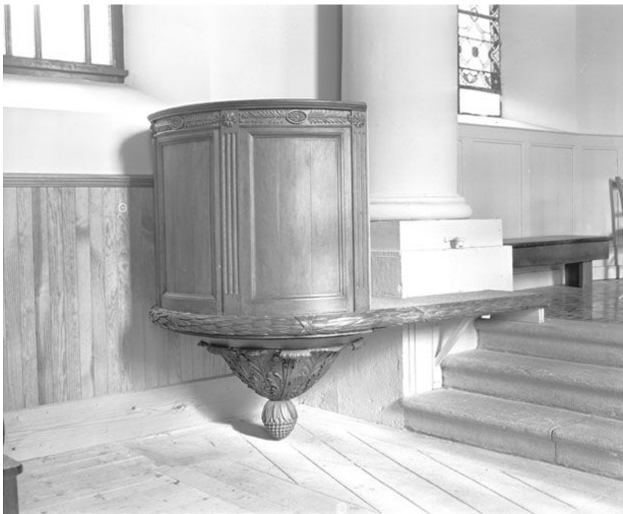
Cuve de la chaire à prêcher.
