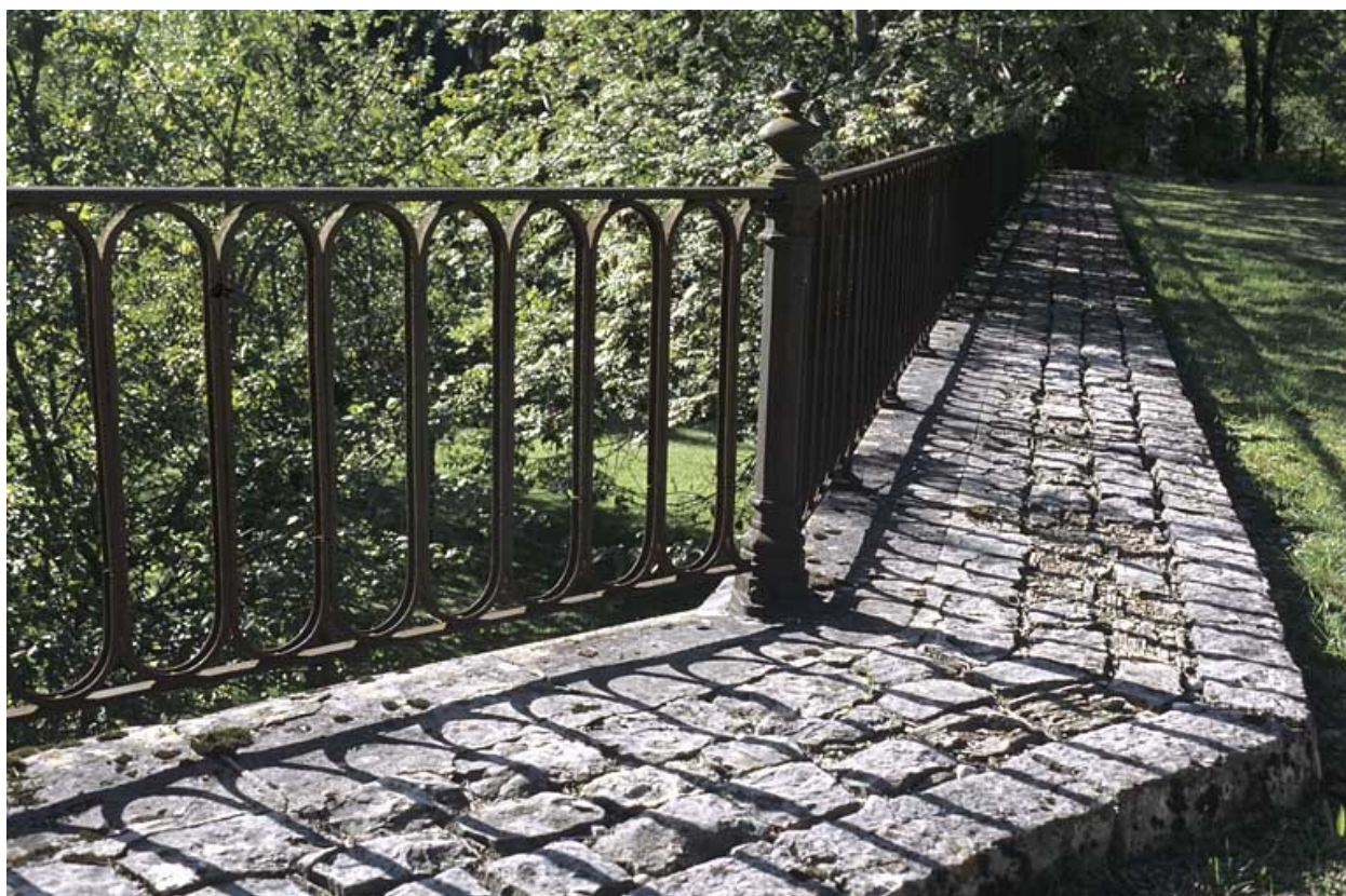
Garde-corps métallique de la cour des voyageurs.
