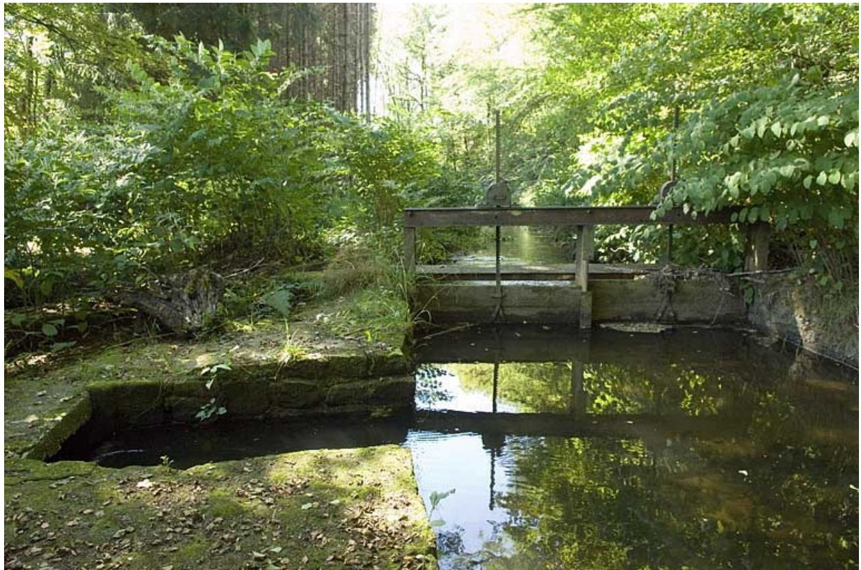
Vannage sur le bief de dérivation.
