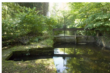
Vannage sur le bief de dérivation. Phot. Jérôme Mongreville IVR43_20067000756NUCA
