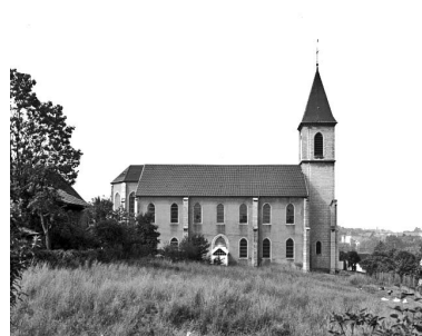
Elévation latérale gauche. Phot. Yves Sancey IVR43_19829000100V
